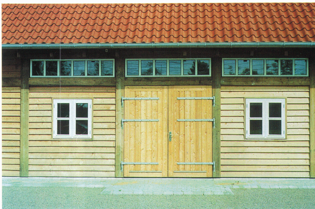
...que pour des revêtements de façade finies de façon transparente.
