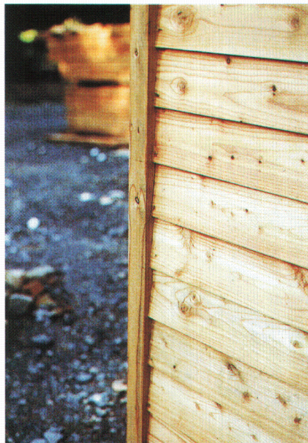
Détails d'un revêtement de façade en mélèze.
