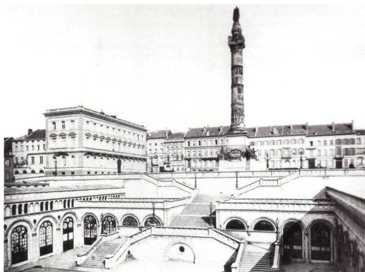
▲ De Congresskolom met de stedenbouwkundige aanleg van J.-P. Cluysenaar. Merk de zwart verkleurende steen van Herzogenrath (SAB, Iconografisch Fonds, J 941)
