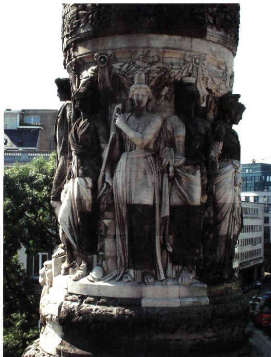
▲ De Allegorie van de Provincieën en de Genius van de Koninklijke Macht, door Eugène Simonis (1810-1882), zuidzijde vóór restauratie. De herstellingen in Euvillesteen zijn duidelijk herkenbaar (foto Regie der Gebouwen, 2000)
