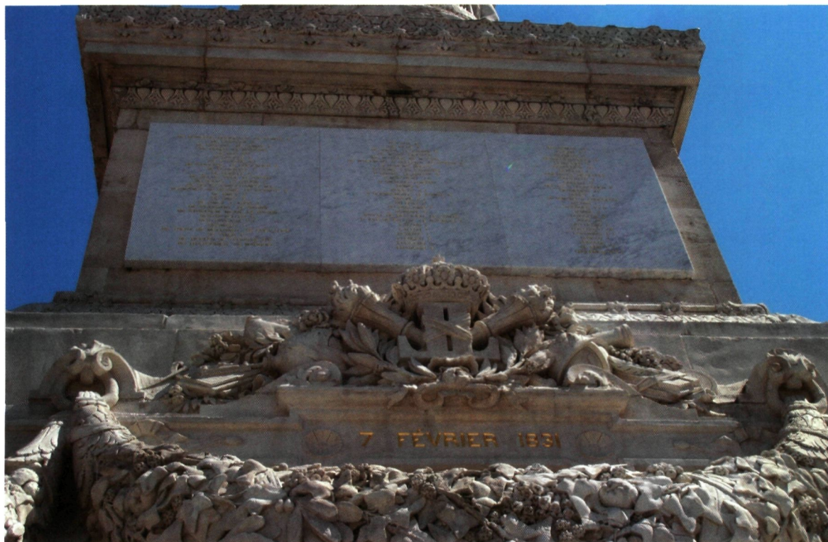
► Westzijde van het middelste derde van de sokkel, na afwerking met 'sterk water' (foto Regie der Gebouwen, 2003)
