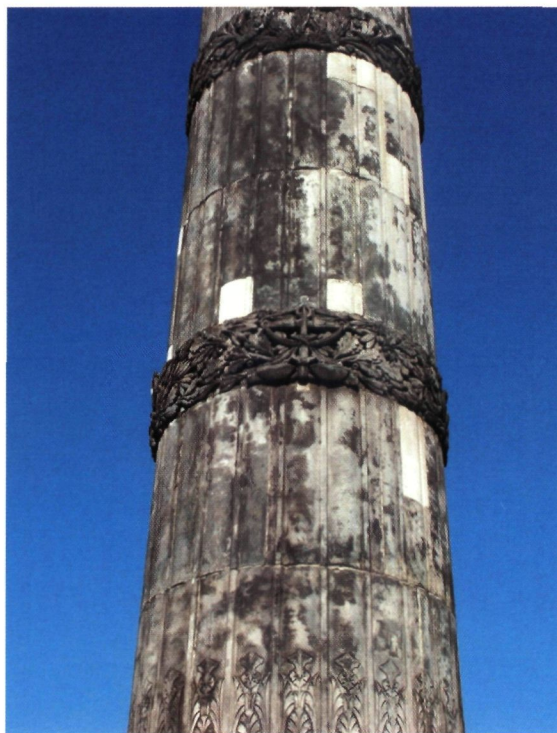
▲ Detail van de schacht, vóór restauratie. De herstellingen in Euvillesteen zijn duidelijk zichtbaar (foto Regie der Gebouwen, 2000)
