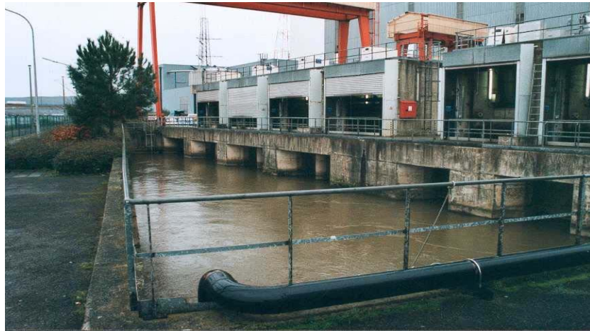
Fond du canal de prise d'eau
