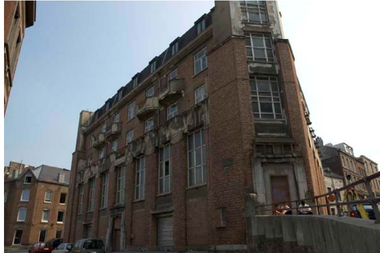
Figure 20. Ancien commissariat de police de la ville de Verviers Façade utilisée pour le test de la DLT
