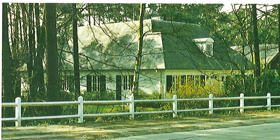
Villa "quatre-façades" dans lotissement boisé (Rixensart). Cliché : MLDK.
