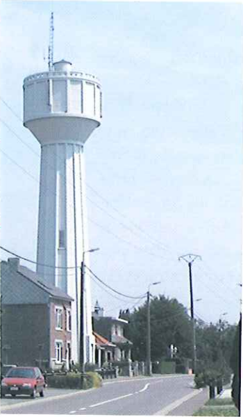
Château d'eau. Cliché : L. Brück.
