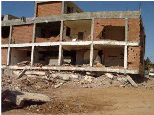
Figure 10.15. Effet de la formation de «rotules plastiques» en tête des poteaux du rez de chaussée. (Boumerdes, Algérie,2003 - Kocaeli, Turquie, 1999)
