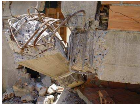
Figure 10.26. Absence d'armature transversale au nœud. Effondrement dû à cette absence au nœud et dans la zone critique du poteau.
