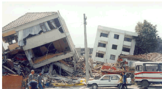
Figure 10.15. Effet de la formation de «rotules plastiques» en tête des poteaux du rez de chaussée. (Boumerdes, Algérie,2003 - Kocaeli, Turquie, 1999)
