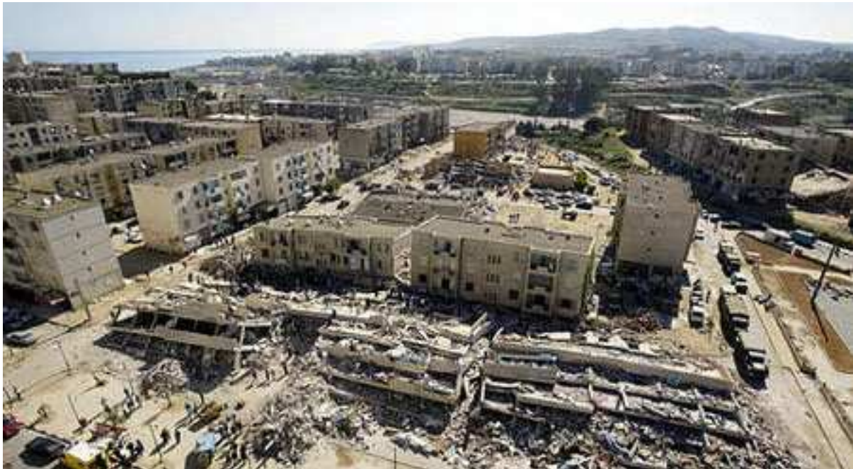
Figure 10.1. Effet du séisme de Boumerdes (Algérie, 2003).
