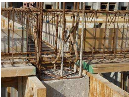
Figure 10.26. Absence d'armature transversale au nœud. Effondrement dû à cette absence au nœud et dans la zone critique du poteau.
