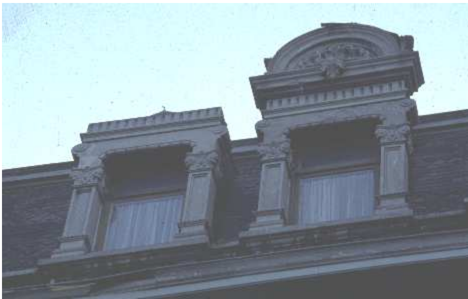
Figure 5.31a). Le fronton de gauche a basculé...voir l'effet à la figure suivante... (situation inchangée à ce jour...)
