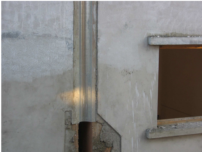
Figure 5.29 d). Joint sismique masqué.
