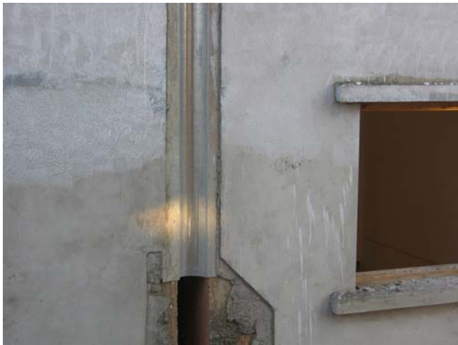
Figure 5.29 d). Joint sismique masqué.
