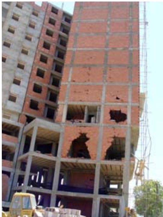
Figure 5.12. Bon comportement d'un bâtiment à noyau (structure primaire) et ossature périphérique (structure secondaire). (Boumerdes,2003).
