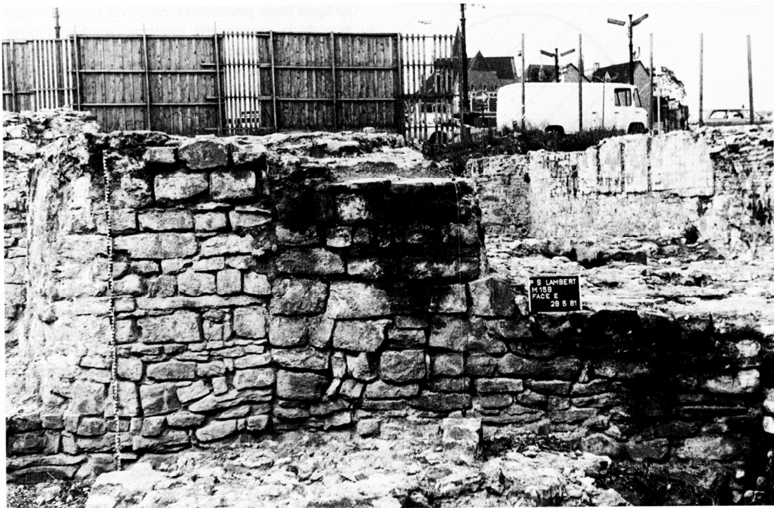
FIG. 5. Phase D : Rhabillage extérieur de la crypte.
