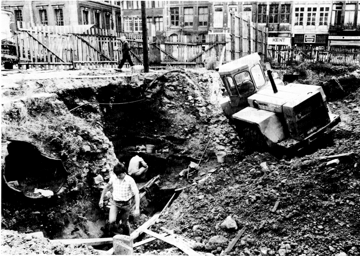
FIG. 6. Fouille précipitée des structures de bois du Haut Moyen Age au moment du remblaiement du chantier oriental pour l'installation d'un parking. Juillet 1981.
