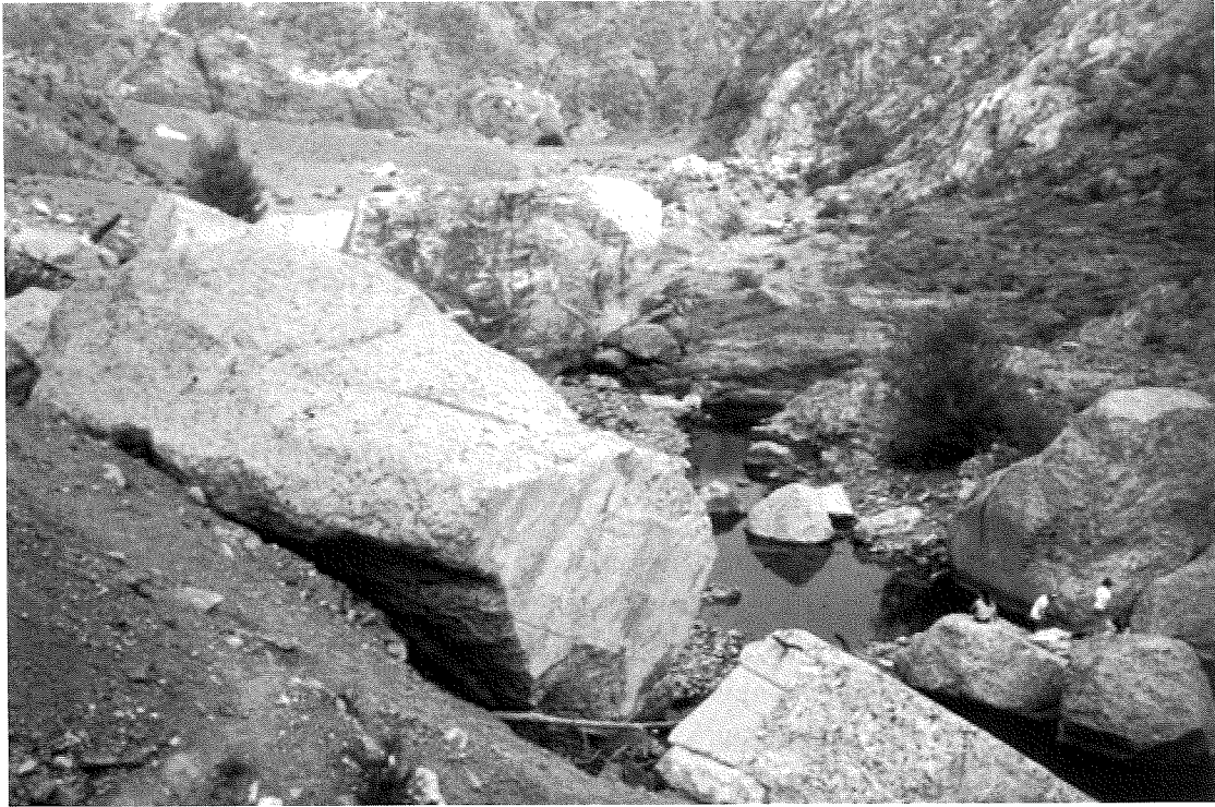
Photo VI.1. – Blocs charriés et vestiges de l'ouvrage, après la rupture instantanée du barrage de Malpasset, France
