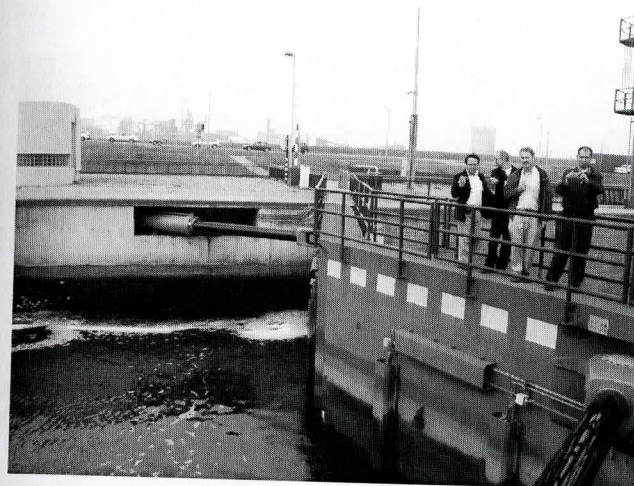
Fig. 13: Reverse Mitre Gates (IJmuiden-NL)
