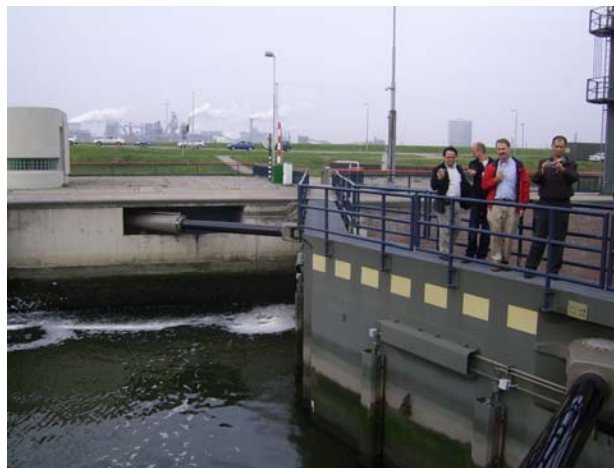
Figure 13 : Reverse Mitre Gates (IJmuiden-NL)
