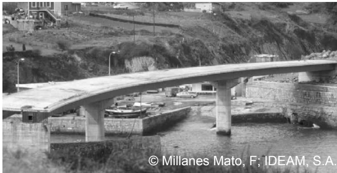
c) Puente sobre la Ría de Ciérvana, Bilbao, 1978 (first example worldwide of double composite action reported).
