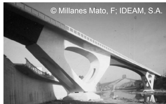
b) Puente del Diablo, Barcelona, 1972 (100 m span and twin composite triangular boxes).
