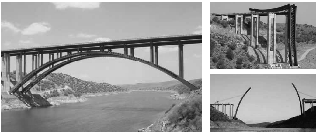
c) Double composite box section: Puente sobre el río Tajo, Alcántara Reservoir, 2006 [51].
