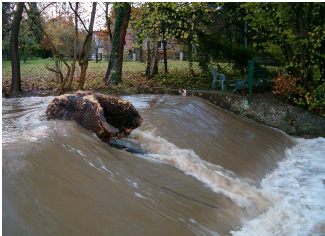
Planche photos 11. Vue du barrage chute + rampe de Mortroux en période d'eau normale avec son échelle à poissons (A, au-dessus) et pendant un coup d'eau qui estompe la chute en aval (B, en-dessous), ce qui crée des conditions hydrauliques de franchissement direct possible par un salmonidé, sans passage par l'échelle.
