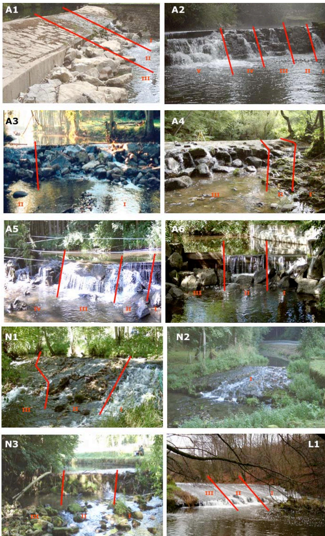
Figure 29. Vue en conditions de bas débit des obstacles étudiés dans l'Aisne (A1-A6), le Néblon (N1-N3) et la Lhomme (L1). Sur chaque photo, les traits en rouge et les chiffres romains correspondants délimitent les différentes parties de l'obstacle sur un plan transversal de la rive gauche à la droite. Rampe : N1, L1. Chute : A2, A6, N3. Rampe + chute : A1, A3, A4, A5, N2.
