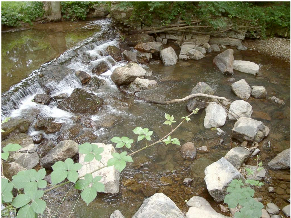
Planche photos 7 : seuil de Aisne 46 MRW sur l'Aisne. Vue d'ensemble
