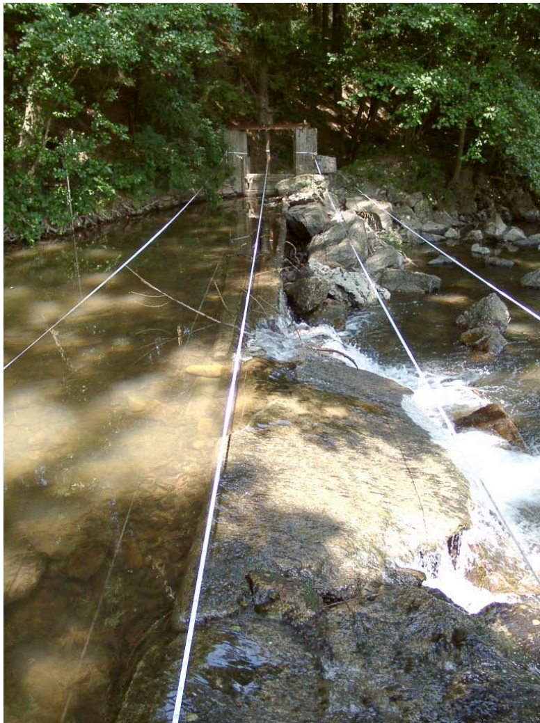
Planche photos 4: seuil de Ninane sur l'Aisne . Description hydraulique
