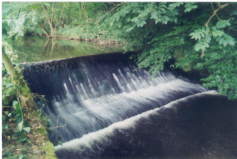
Planche de photo 8. Exemple de déversoir en S particulièrement difficile à franchir par les poissons.
