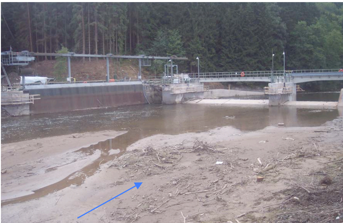
Photo 7: Retenue de Lorcé vidée lors de la construction de la nouvelle échelle à poissons (19/08/06)
