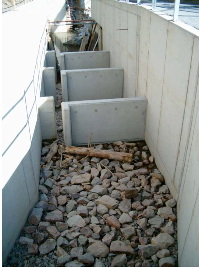
Photo 5: Vue de la nouvelle échelle à poissons de Lorcé en avril 2007.
