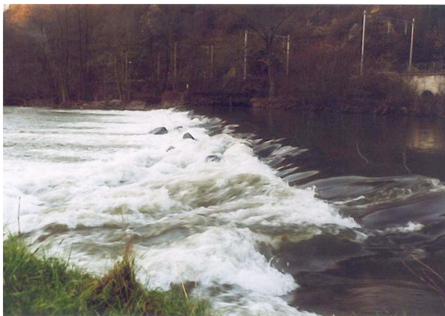
Photos 1 A-B: Barrage en enrochement de Belle-Roche (Amb 01) à Comblain-au-Pont à 1,330 km de l'embouchure dans l'Ourthe. Au-dessus (A): situation pendant l'étiage (05/09/02). En-dessous (B) : situation pendant l'hiver (18/12/98).
