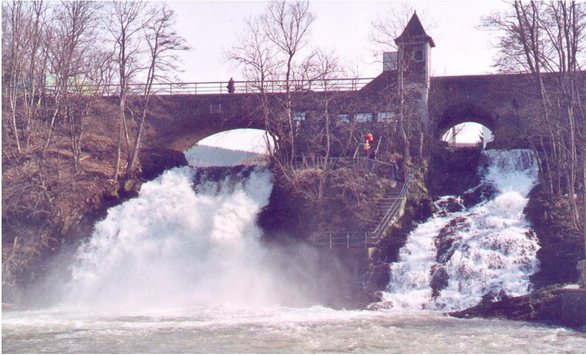
Photo 10: La cascade de Coo (obstacle Amb 05) sur le cours principal de l'Ambève
