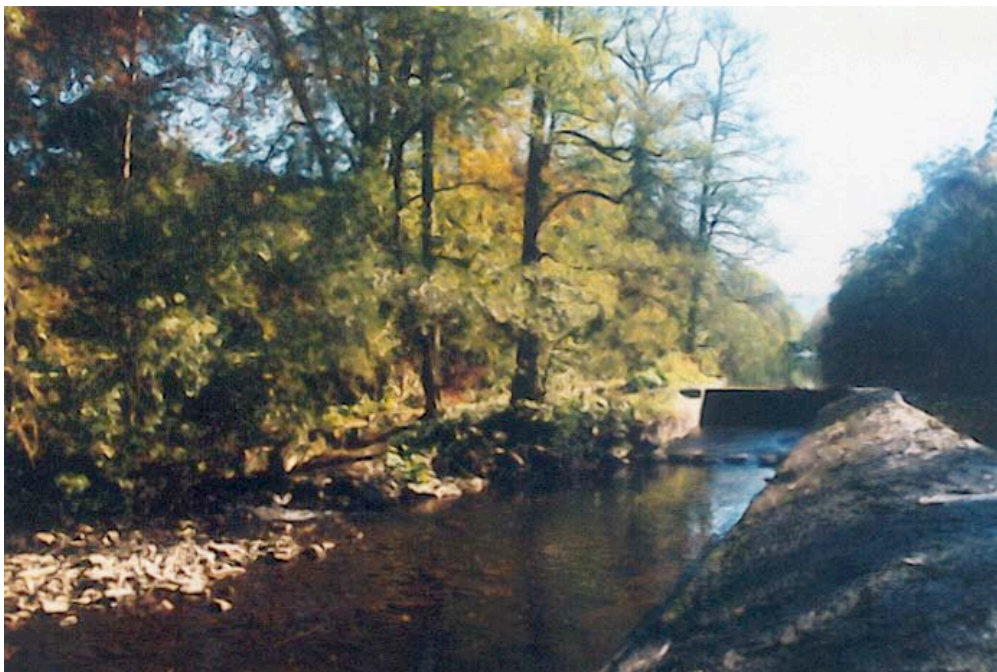
Photos 2 A-B: Barrage de Raborive-Aywaille (Amb 02) à 6,940 km de l'Ourthe. Au-dessus (A): vue hivernale (30/03/07) de l'ouvrage au niveau de l'angle supérieur du déversoir fixe qui est franchissable par certains poissons quand le débit est suffisant. En-dessous (B): vue de la même partie de l'ouvrage en condition d'étiage (16/10/03) et quand le turbinage hydro-électrique entraîne un arrêt complet de l'écoulement de l'eau.
