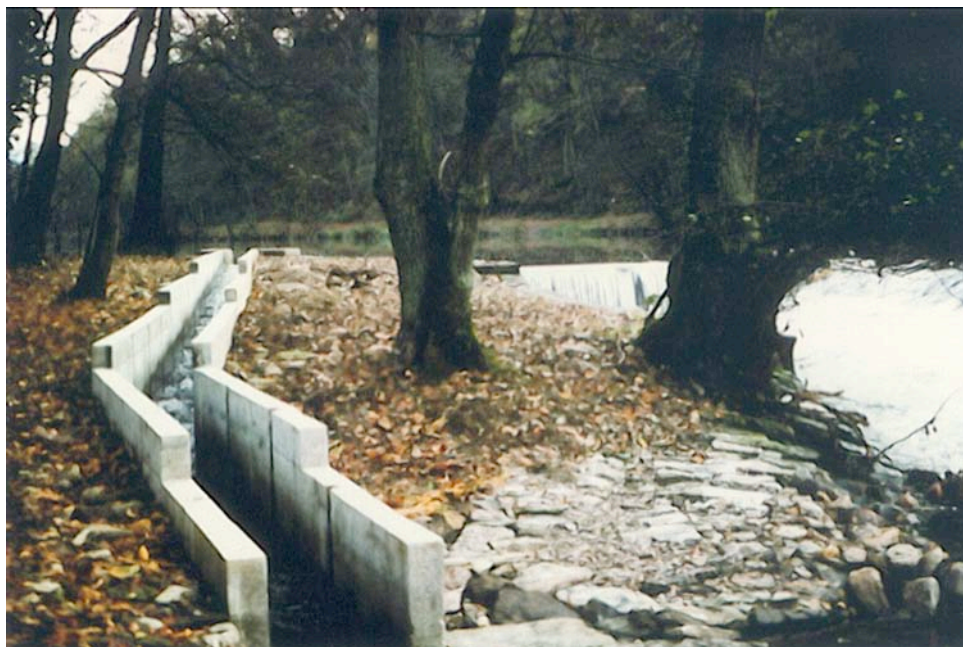
Photo 3: Ancienne échelle à poissons aménagée au barrage de Raborive dans les années 1970.
