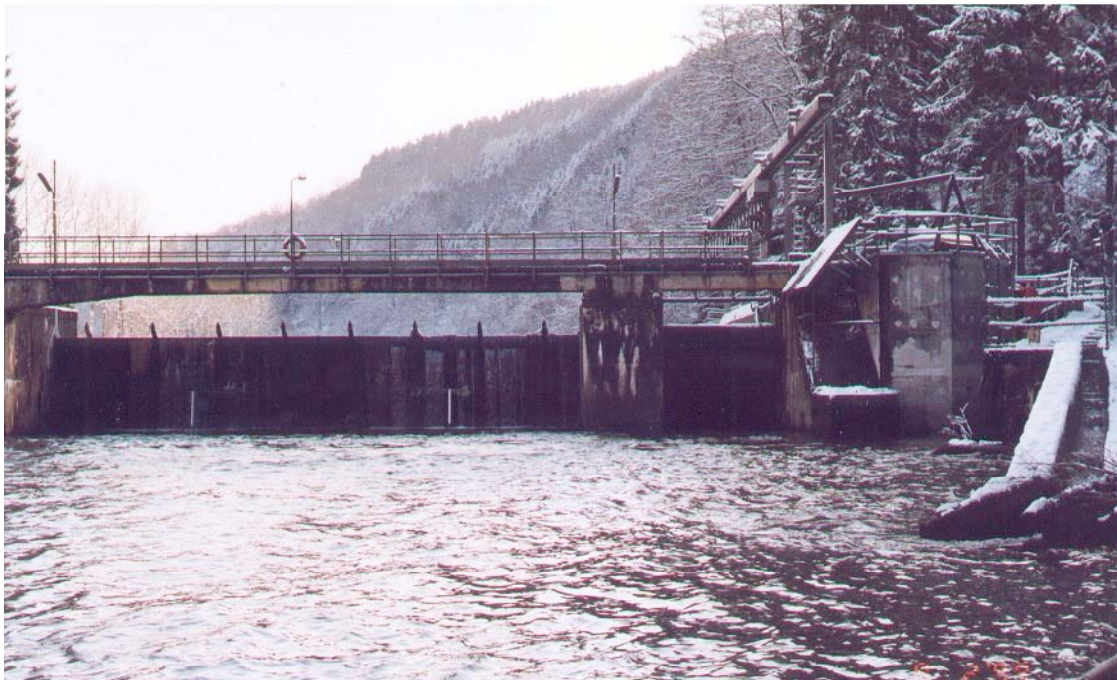
Photo 4: Barrage à vannes mobiles de Lorcé (obstacle Amb 04) à 14,920 km de l'Ourthe qui crée une retenue alimentant par conduite forcée la centrale hydro-électrique de Hé de Goreu. On remarque sur la droite l'entrée de l'échelle à poissons non fonctionnelle construite en 1932
