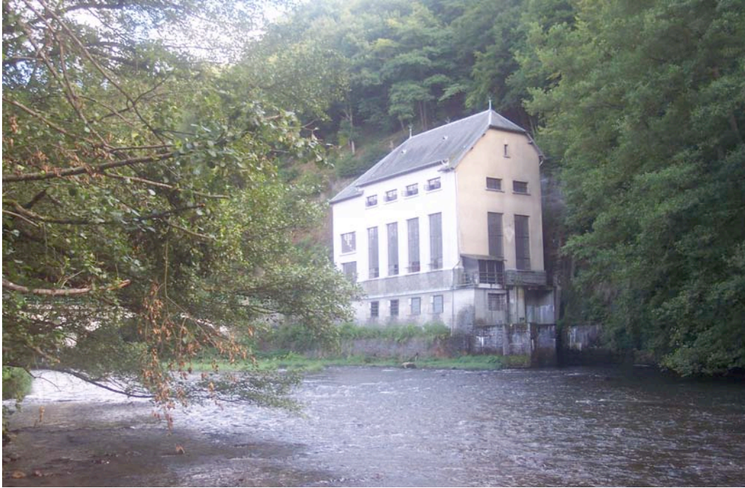
Photo 8: Centrale hydroélectrique Electrabel de Hé de Goreu (18/08/06).
