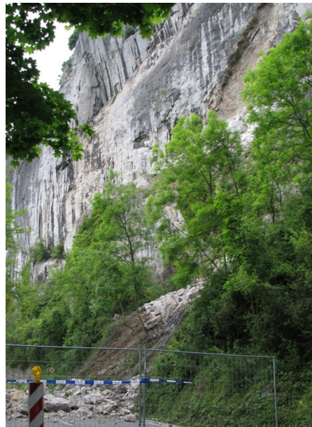
Route barrée suite à l'éboulement d'une paroi à Lustin (Commune de Profondeville).
