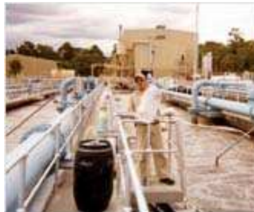
Station d'épuration ( stabilisation des boues )
