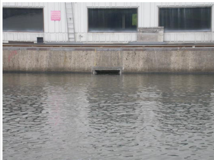
Vue amont de l'exutoire à Lixhe
