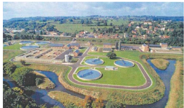
Station d'épuration de Wégnez à Pepinster en rive droite de la Vesdre
