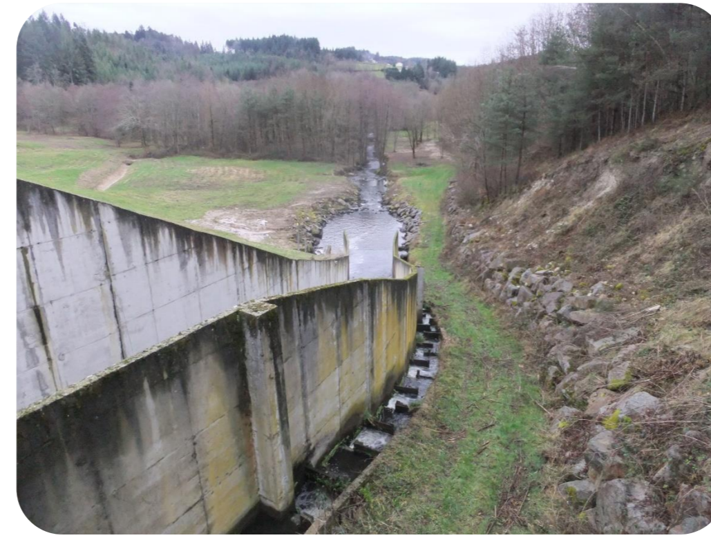
Chenal secondaire non revêtu et échelle à poissons existante
