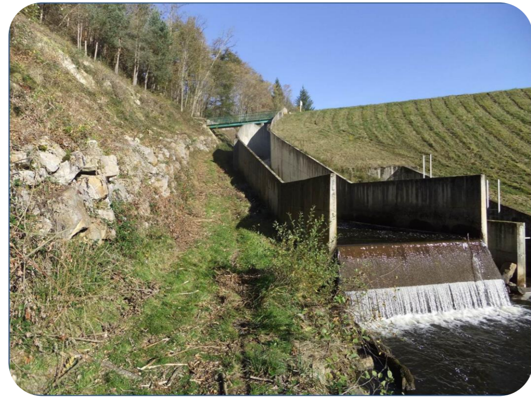
Extrémité aval des coursiers
