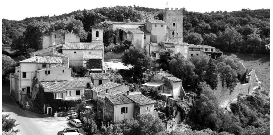
Fig. 1 - Esparron-de-Verdon, château et village, vue depuis l'Ouest. Cl. M. Vivas © Conseil Général des Alpes-des-Hautes-Provence.
