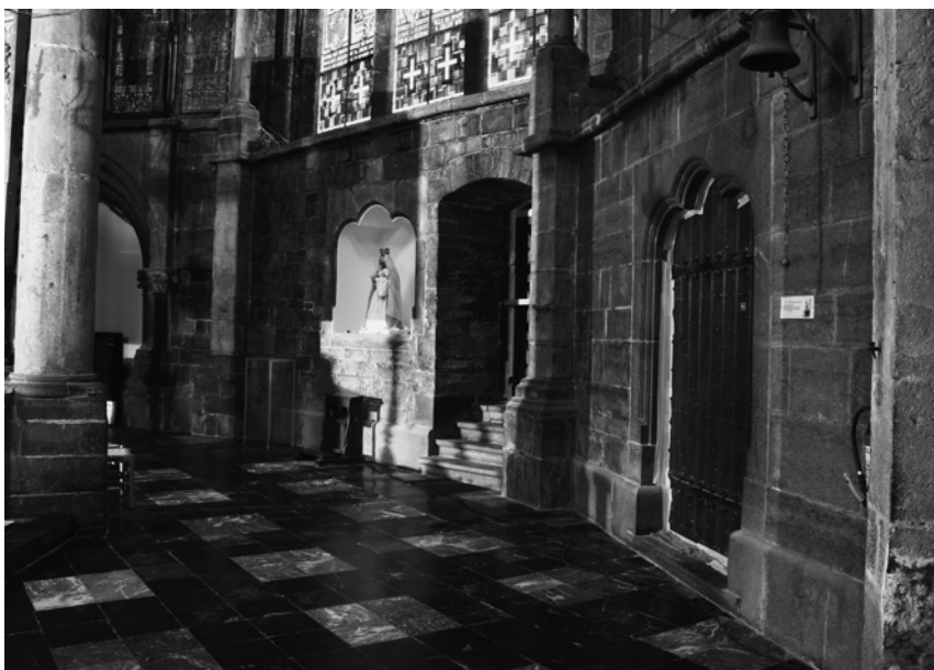
Fig. 16.- Vue générale du déambulatoire et de ses aménagements néogothiques : la niche et la porte à linteau trilobé. Le pan de mur situé à droite a été entièrement reparablement. © Antoine Baudry, 2014.
