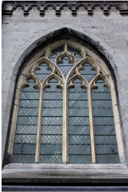
Fig. 27.- Vue détaillée d'un des remplages flamboyants des parties hautes de la nef. © Antoine Baudry, 2014.
