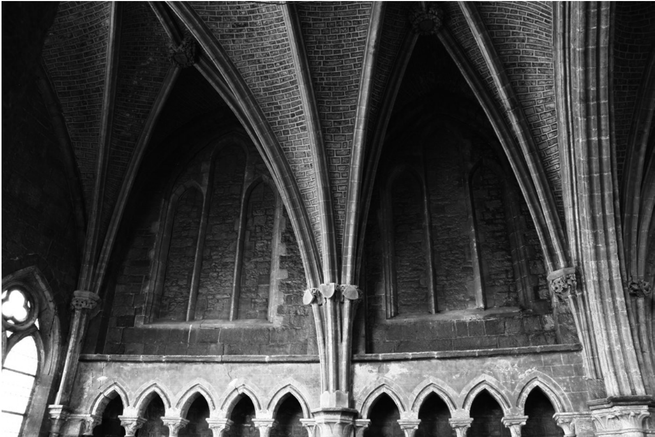
Fig. 20.- Contrairement à leurs homologues du croisillon sud, les deux triplets orientaux du croisillon nord du transept ne sont pas « ré-ouverts » au XIX e siècle. L'observation des parements tend à prouver que ces éléments étaient dès l'origine conçus pour être aveugles. © Antoine Baudry, 2014.
