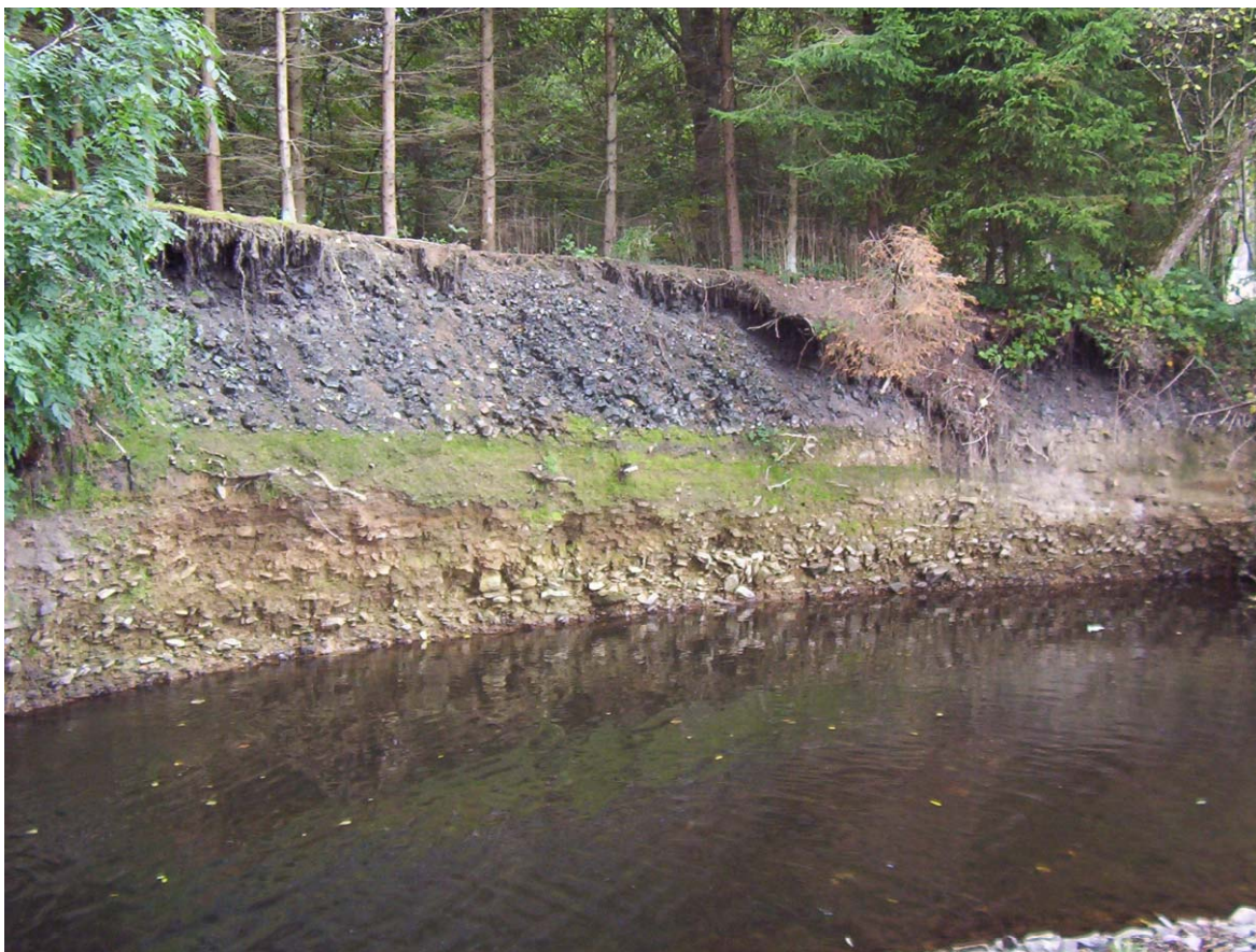
Injection de scories vitreuses de haut fourneau par érosion latérale (crassier de Neucy – Lienne, Ardenne)
