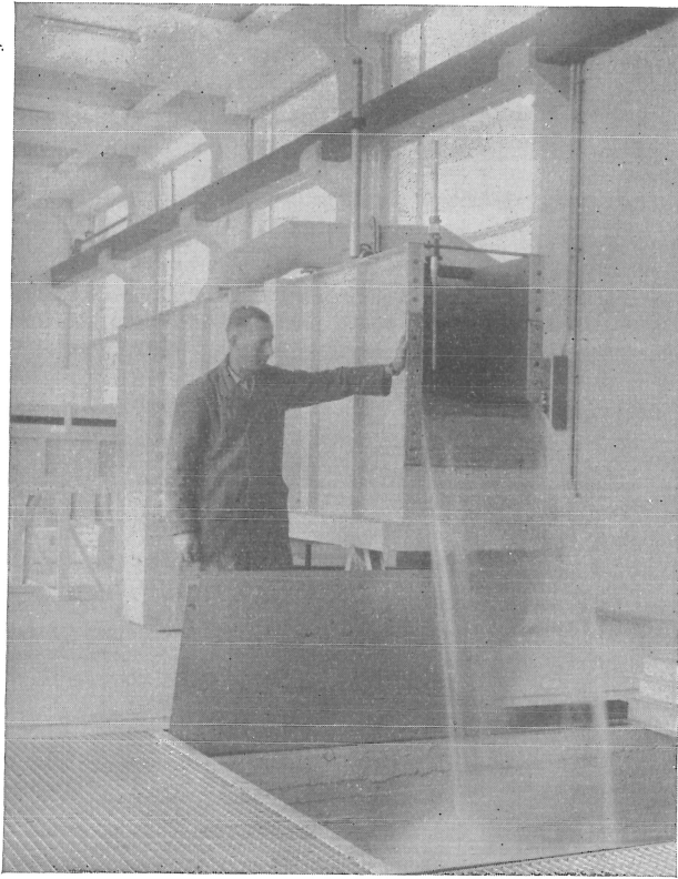
FIG. 8. — Ecoulement sur déversoir rectangulaire en mince paroi.
