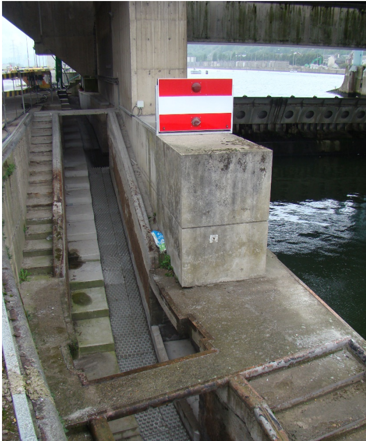
Figure 12 : Nouvelle passe à anguilles sur le barrage d'Ivoz Ramet
