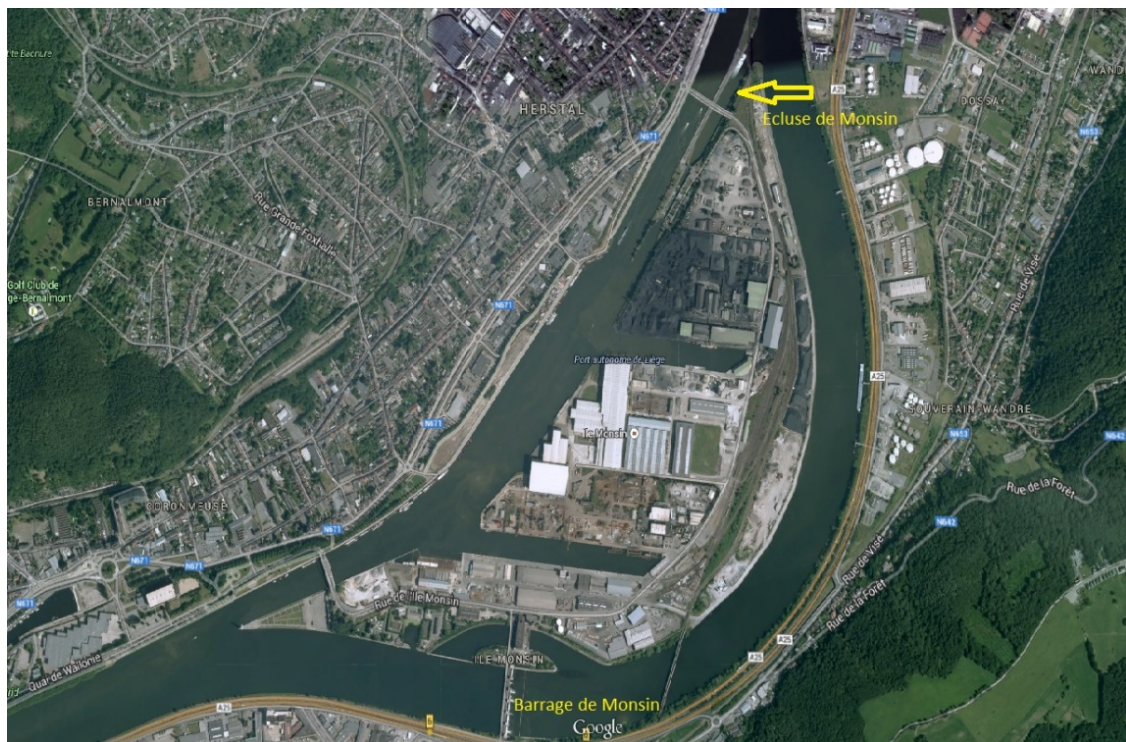
Figure 10. Vue aérienne du barrage de Monsin et de l’écluse de Monsin par où les poissons peuvent bifurquer vers le canal Albert et remonter vers la Meuse, sans passer par l’échelle à poissons du barrage de Monsin.
