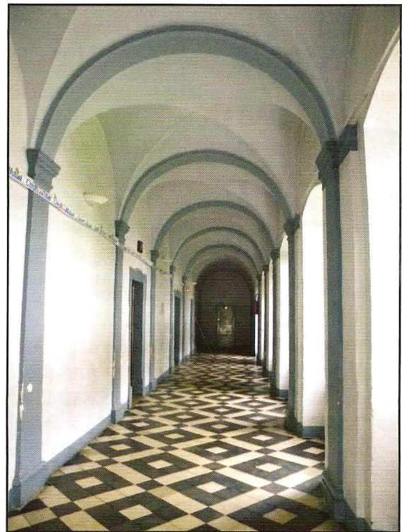
ill.16. Haguenau, rue du Maréchal Foch, ancien couvent des Annonciades célestes (actuel collège Foch), rez-de-chaussée de l'aile sud (second quadrilatère), couloir longitudinal, 2011, Photo : Julie Piront
