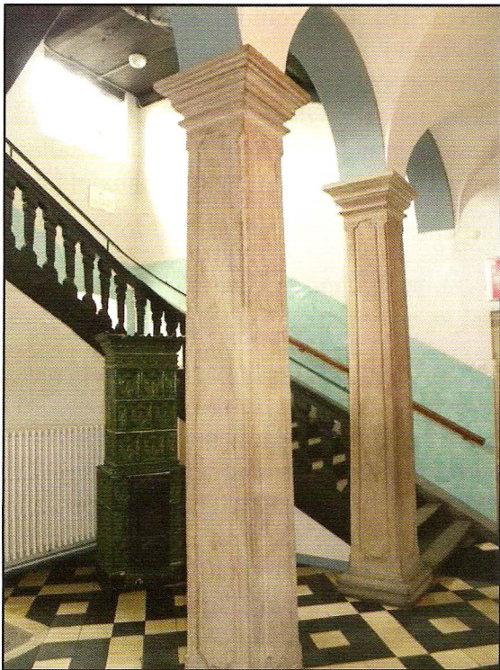
ill.15. Haguenau, rue du Maréchal Foch, ancien couvent des Annonciades célestes (actuel collège Foch), rez-de-chaussée de l'aile nord (premier quadrilatère), cage d'escalier, 2011, Photo : Julie Piront
