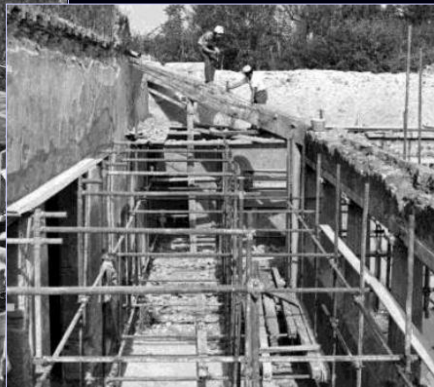
Restauration et couverture du péristyle en 1973
