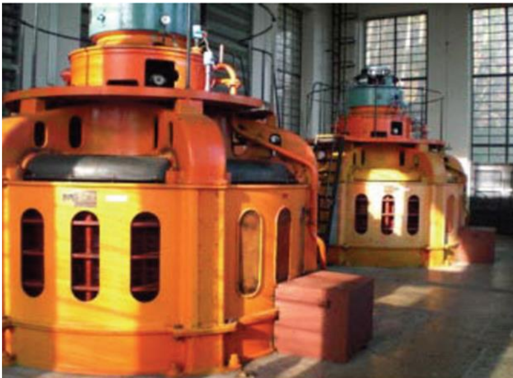
Figure 12 : Turbines FRANCIS de la CHE de Heid de Goreux sur l'Amblève
