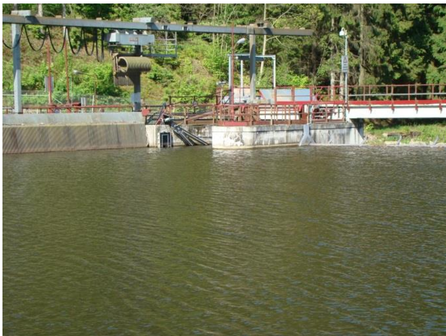
Figure 8 : Vue amont du barrage de Lorcé avec la présence de l'exutoire de dévalaison en rive gauche juste en aval du plan de grille
