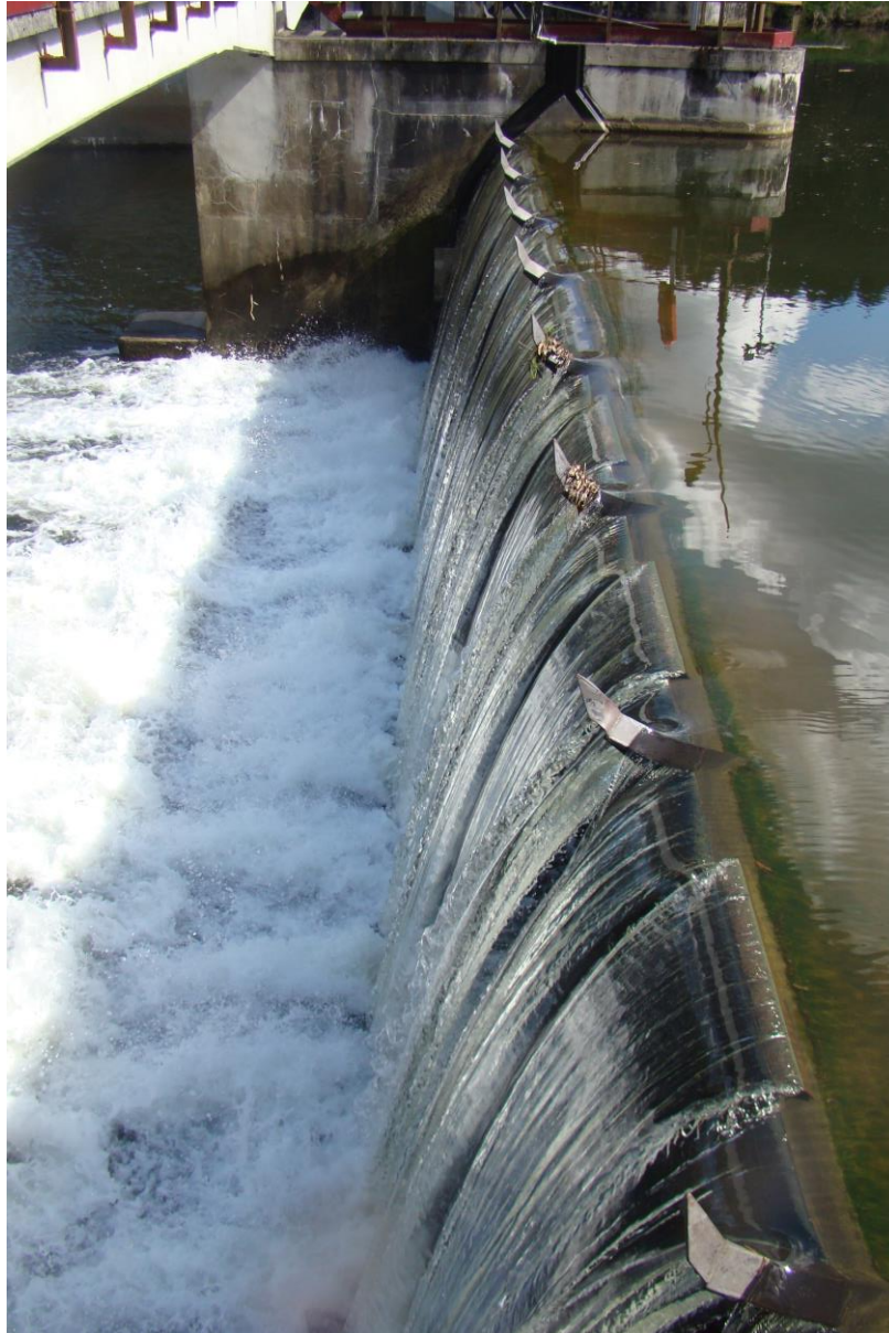
Figure 24 : Vue latérale de la vanne mobile du barrage de Lorcé lors de son abaissement partiel durant les suivis comportementaux de smolts de saumon atlantique au printemps 2016
