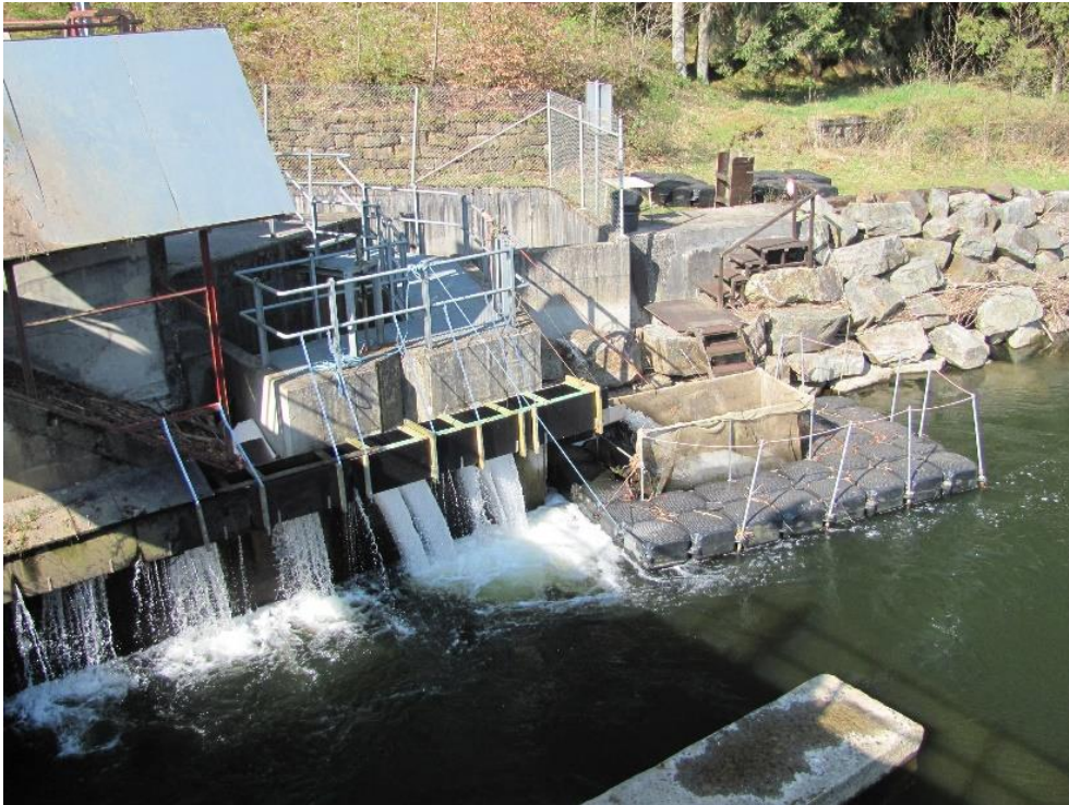
Figure 15 : Vue globale du piège de capture à la dévalaison au niveau du barrage de Lorcé
