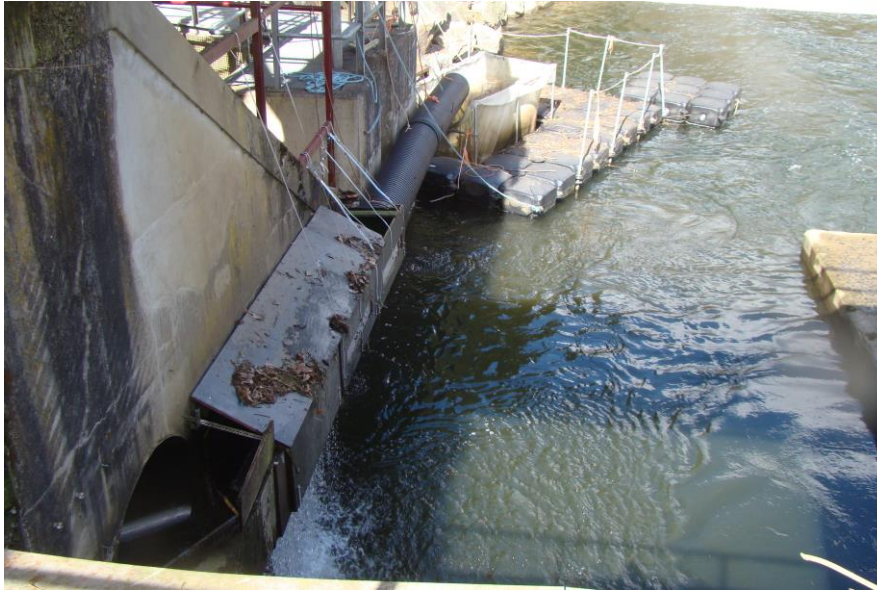
Figure 38 : Piège de capture de dévalaison installé au niveau de l'exutoire de dévalaison du barrage de Lorcé
