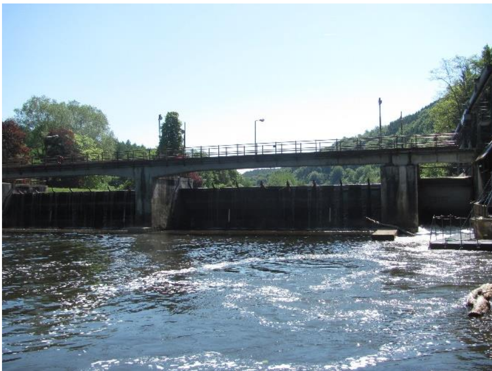
Figure 4 : Vue aval du barrage de Lorcé. En partant de la gauche, deux vannes mobiles de 17m de long et une vanne secteur de 3m de long
