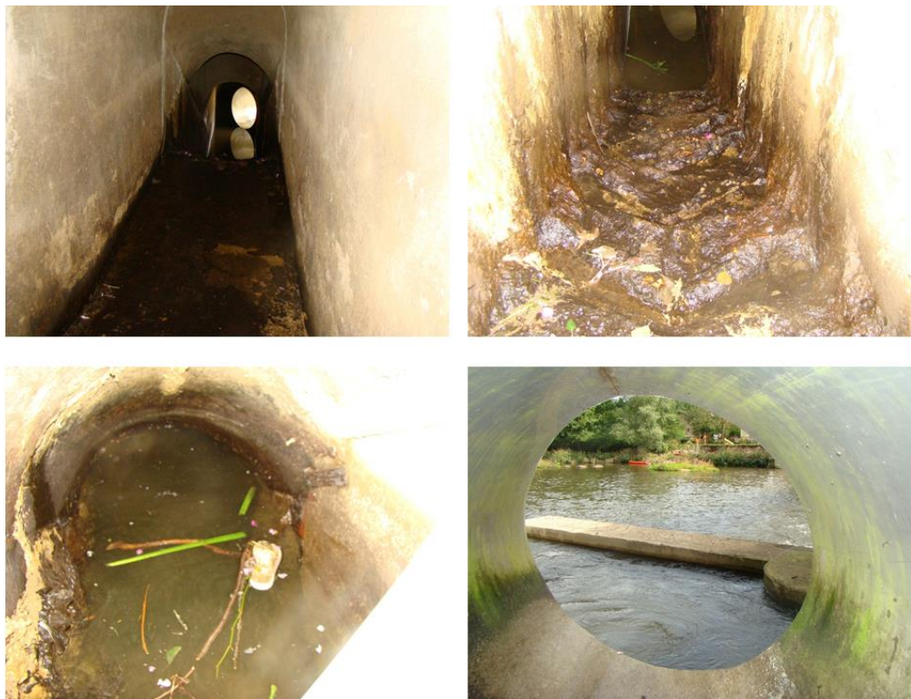
Figure 10 : Vues intérieures de l'exutoire de dévalaison : vue de l'amont (haut à gauche), vue du milieu (haut à droite), zone de retrait aval sortie (bas à gauche) et sortie de l'exutoire (bas à droite)
