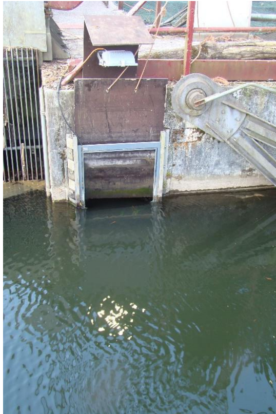
Figure 9 : Entrée de l'exutoire de dévalaison du barrage de Lorcé
