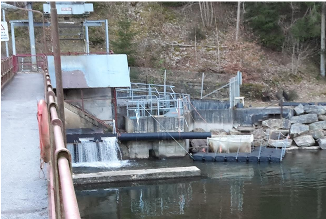
Figure 18 : Vue d'ensemble du piège de capture de dévalaison (mars 2016)
