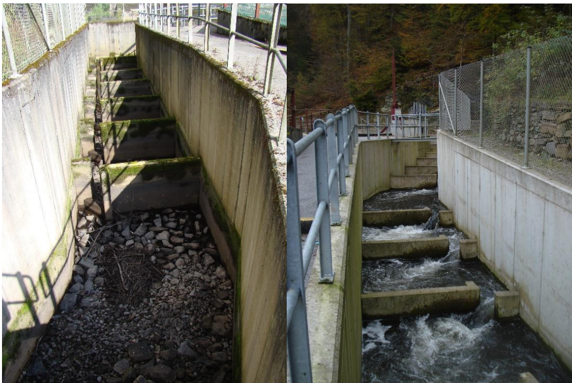
Figure 7 : Echelle à poissons de Lorcé à sec (gauche) et en fonctionnement (droite)
