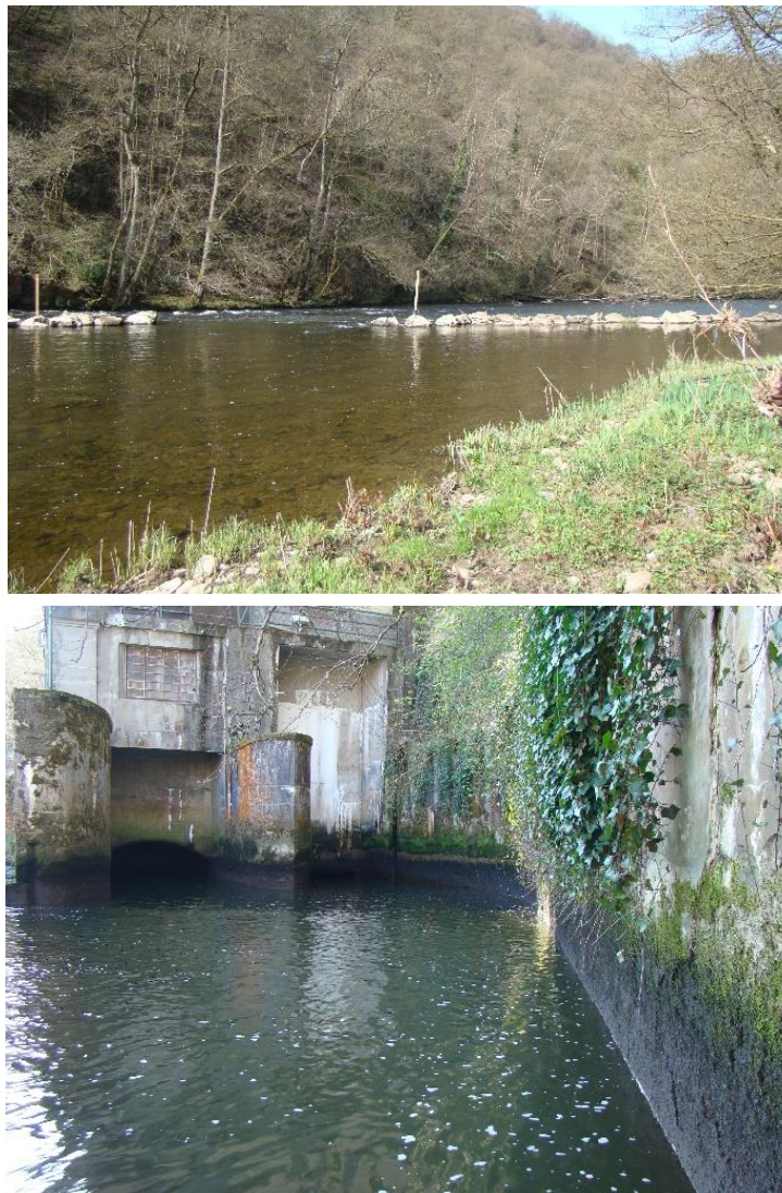
Figure 14 : Vue amont de l'enrochement à la fin du débit réservé (en haut) et vue aval du canal de fuite de la centrale hydroélectrique de Heid de Goreux (à l'arrêt)
