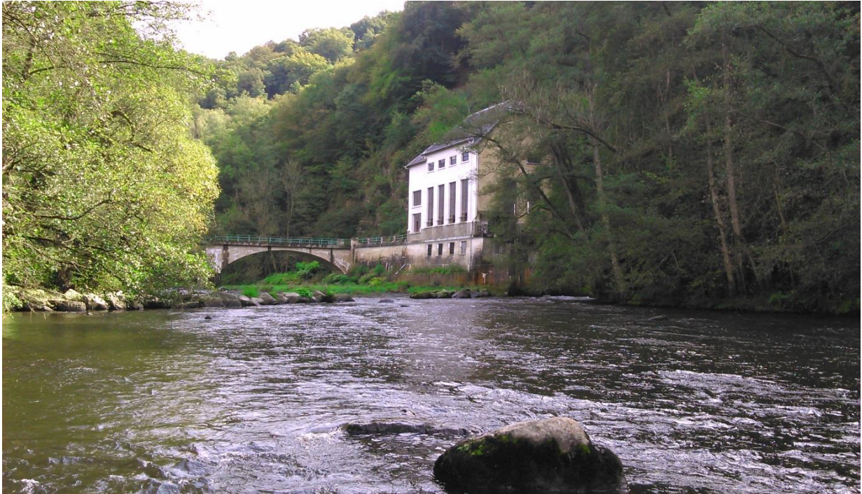
Figure 11 : Vue aval de la centrale hydroélectrique de Heid de Goreux avec la présence de l'énrochement et de son échancrure
