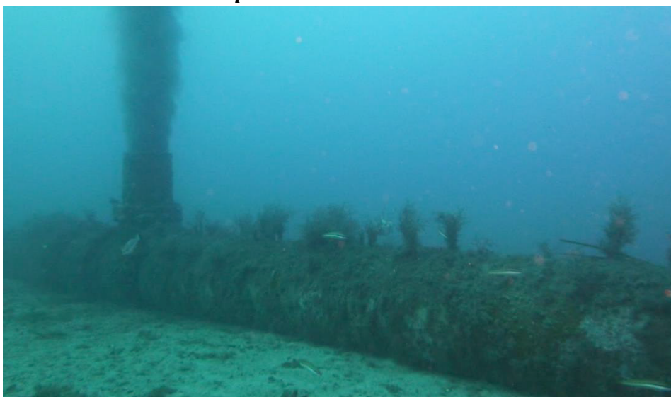
Figure 2-8: Bouche de sortie de la station d'épuration de Calvi (STARESO)
