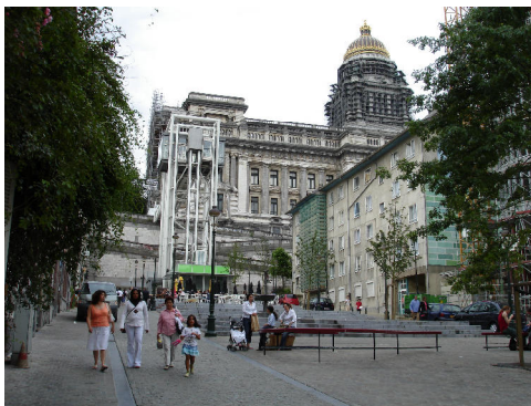
Dénivellation importante entre la place Bruegel et la place Poelaert (Photo : S. Reiter).
