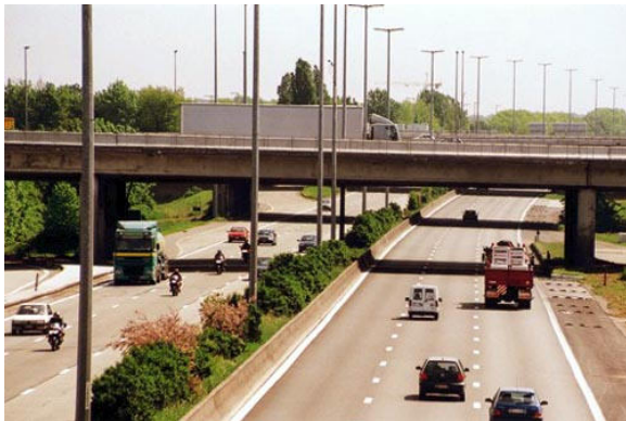
Système autoroutier (Photo : K. De Myttenaere)
