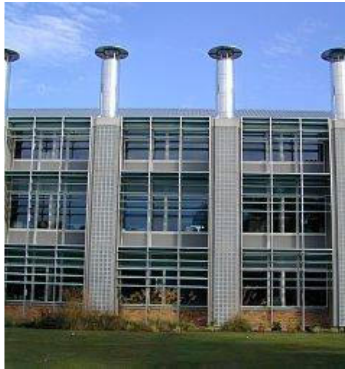
Cheminées solaire du BRE (Photos : S. Reiter).
