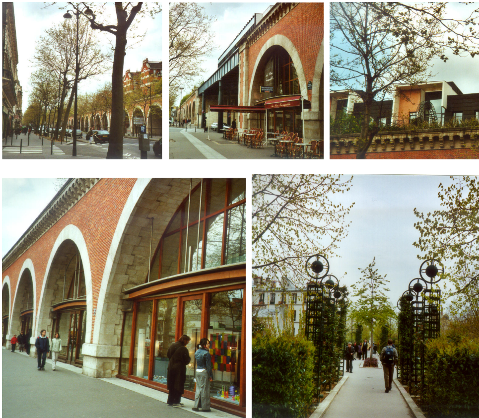
Rénovation urbaine du viaduc de la Bastille, à Paris. (Photos : S. Reiter).
