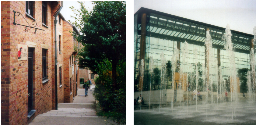
Différents types de matériaux du point de vue acoustique (Photos : S. Reiter).
