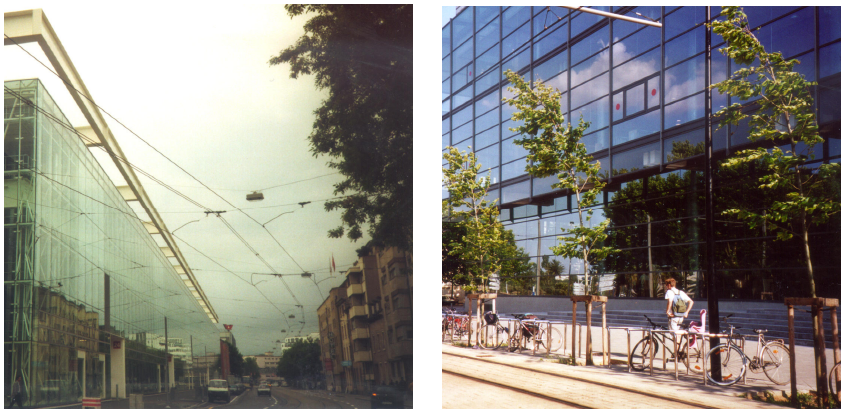
Longues façades réfléchissantes (Photos : S.Reiter).
