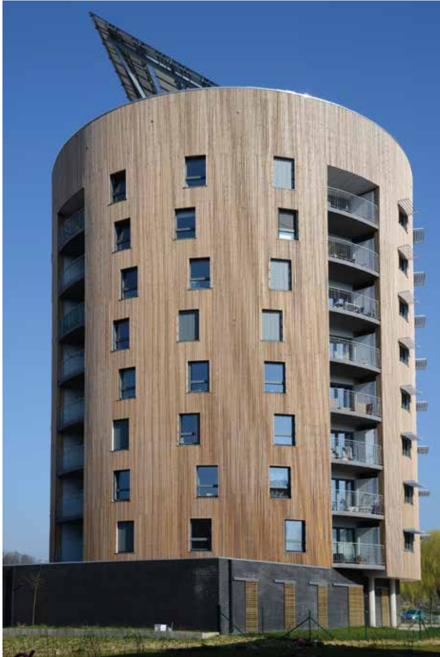
Tour Passive de 35 logements publics à Saint-Vaast (La Louvière) © Fabrice Dor (SPW DGO4)
