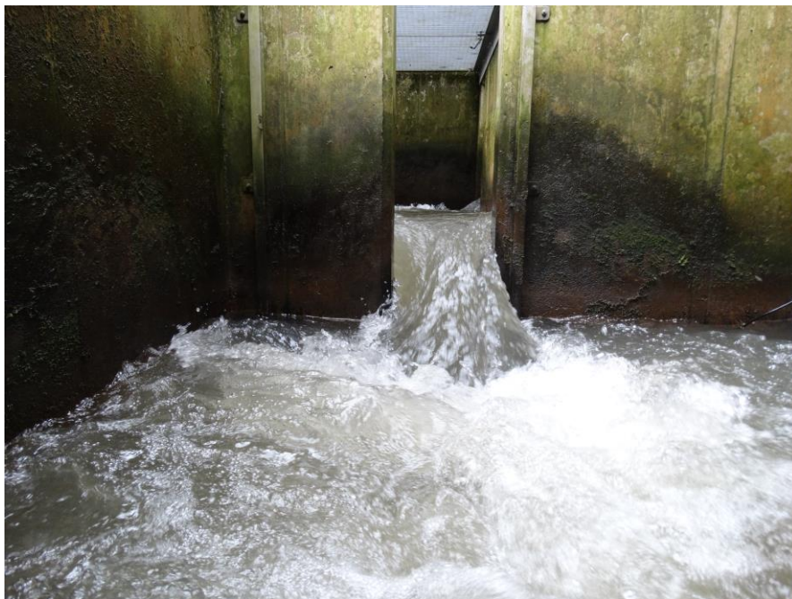
Figure 29 : Vue aval d'une échancrure amont (n°6, tableau 8) de l'échelle à poissons du barrage du Maka
