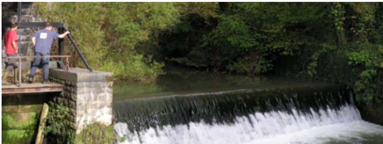
Figure 2 : Vue aval du barrage du Maka sur le Bocq avant aménagement (source : projet Walphy)
