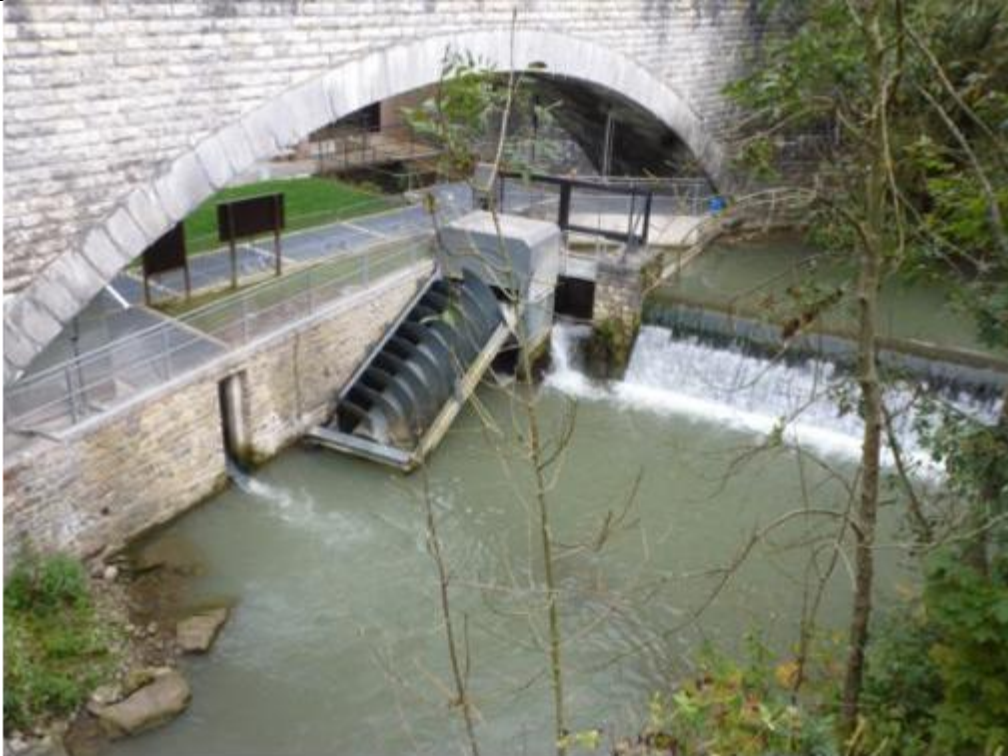
Figure 3 : Vue aval du complexe barrage du Maka - échelle à poissons - vis d'Archimède
