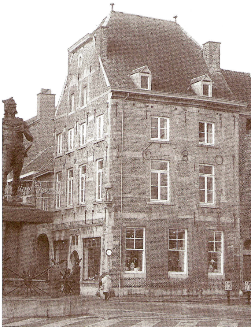
Fig. 6. Tongres. Maison en architecture traditionnelle mosane sur la Grand Place, au coin de la rue Saint-Trond, datée par les ancrs de 1680, cliché de l'auteur, état actuel.
