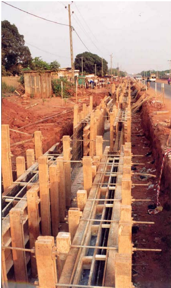
Photo 4: Caniveau en construction dans le cadre du projet ABOK
