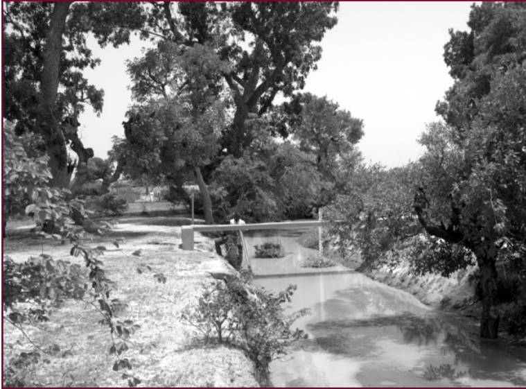
Figure 9.3. Station hydrométrique de suivi du transport solide sur une section de retenue d'eau sur le site de Kierma (Kombissiri).
