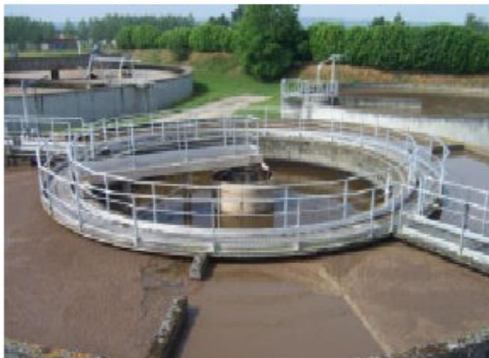
Figure 4 : Épaississement gravitaire des boues (Degrémont, 1989)
