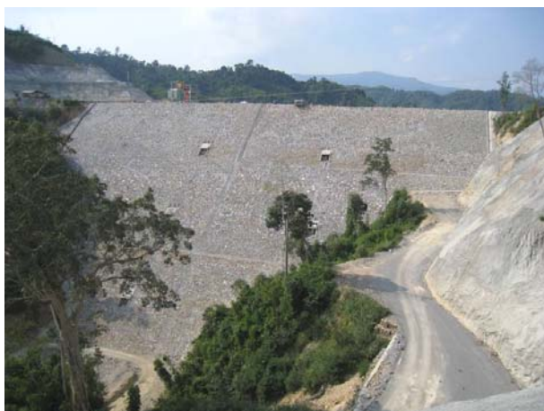
Barrage de Nam Lik 1-2, en voie d'achèvement (1/2010)
