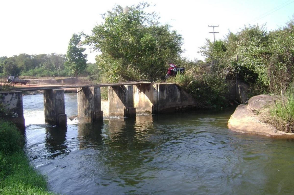
Barrage de dérivation pour l'irrigation
