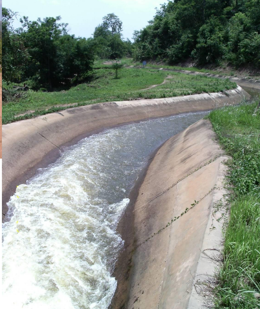
Canal d'irrigation primaire, en aval du bassin de régulation du barrage Nam Mang 3
