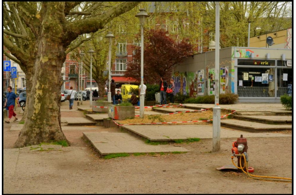
Figure 45 : La place de l'Yser. On voit ici, les dalles qui amènent à l'entrée du théâtre, mais qui créent un parcours semé d'embuches pour le piéton.
