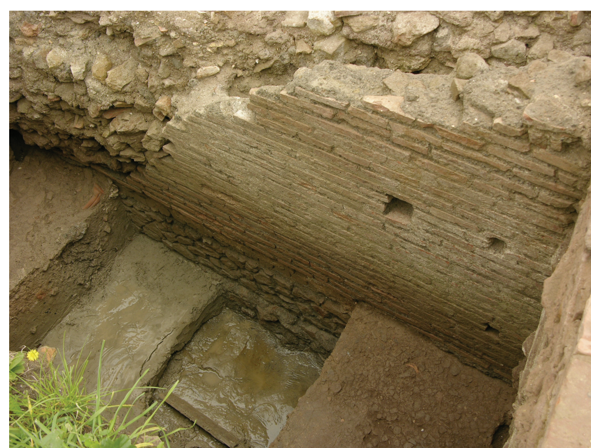
Fig. 1 : Mur périphérique occidental en opus testaceum de la Domus a Peristilio , découvert dans le sondage S, contre lequel venait s'appuyer l'un des remblais étudiés Cliché S. Aubry.
