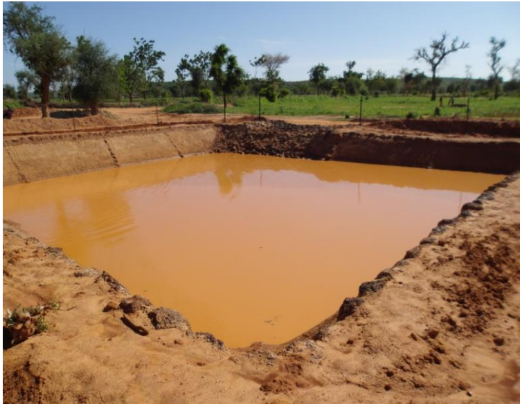
Bassin de collecte d'eau de ruissellement
