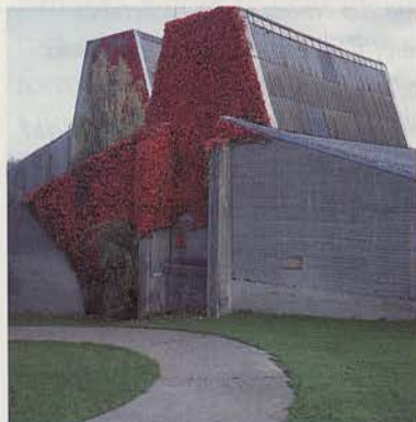
Colonne du porche d'accès à l'Institut de Chimie
