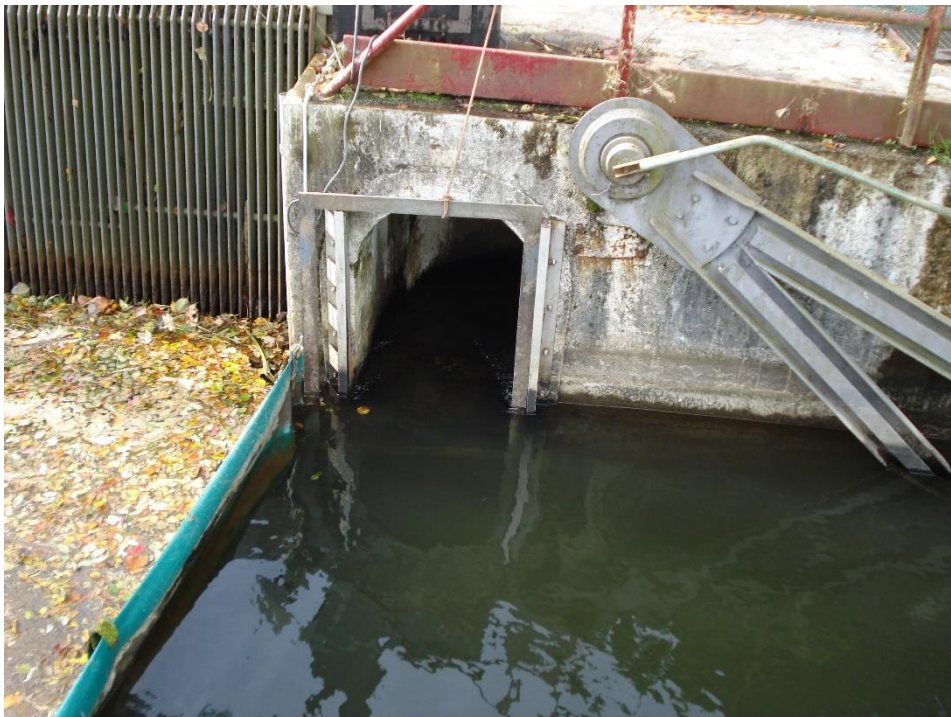
Figure 8 : Entrée de l'exutoire de dévalaison du barrage de Lorcé avec la drome
