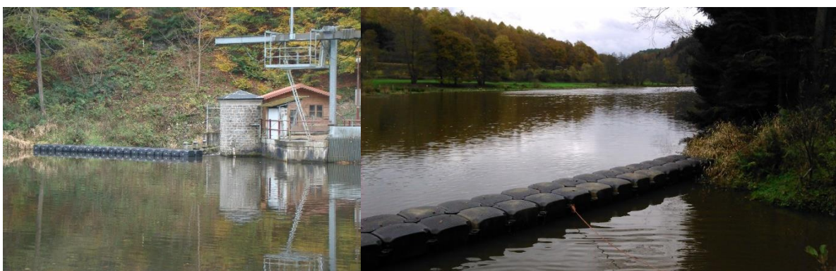
Figure 4 : Drome flottante située en amont de la prise d'eau de l'échelle à poissons du barrage de Lorcé : constituée d'un ensemble de pontons flottants
