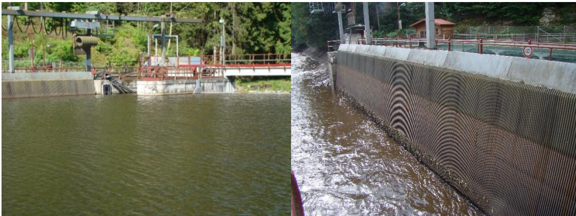
Figure 4 : Vue amont du barrage de Lorcé avec son plan de grille. Gauche : plan d'eau rempli ; droite : plan d'eau vide lors de la maintenance des vannes mobiles (août 2015)
