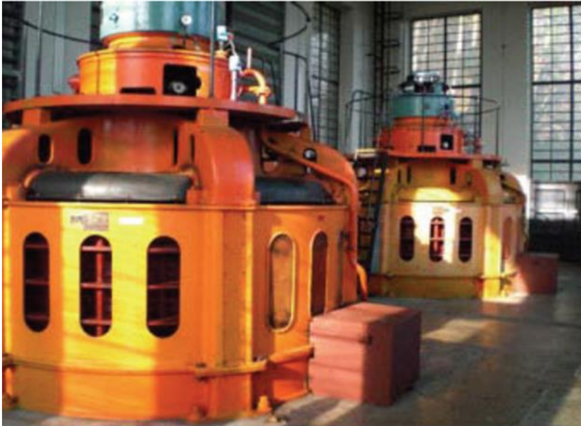
Figure 11 : Turbines FRANCIS de la CHE de Heid de Goreux sur l'Amblève
