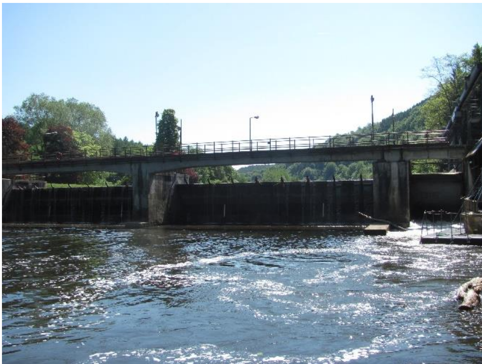
Figure 2 : Vue aval du barrage de Lorcé. En partant de la gauche, deux vannes mobiles de 12m de long et une vanne secteur de 3m de long
