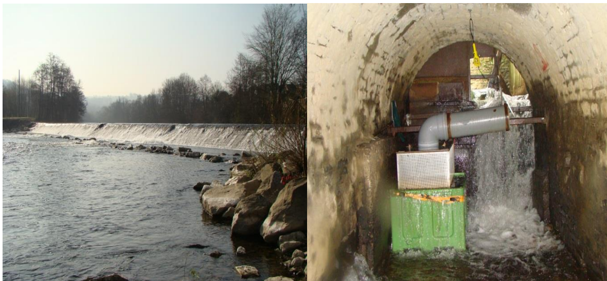
Figure 8 : Site de Méry (Ourthe) équipé d'un barrage rampe (à gauche) et d'un exutoire de dévalaison muni d'un piège de capture (à droite) au niveau de la centrale hydroélectrique de Méry
