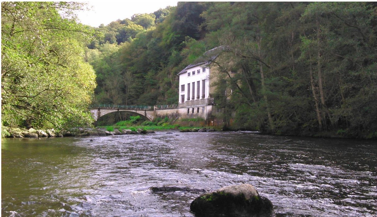
Figure 10 : Vue aval de la centrale hydroélectrique de Heid de Goreux avec la présence de l'enrochement et de son échancrure
