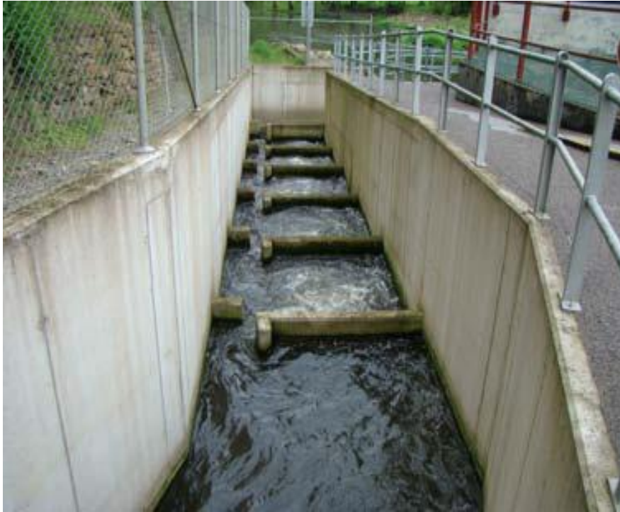
Figure 1 : Echelle à poissons moderne à bassins avec fentes verticales du barrage de Lorcé aménagée en 2007
