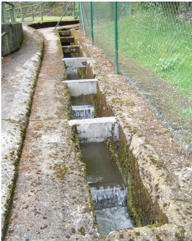
Figure 5 : Vue aval de l'ancienne échelle à poissons du barrage de Lorcé (avant 2007)
