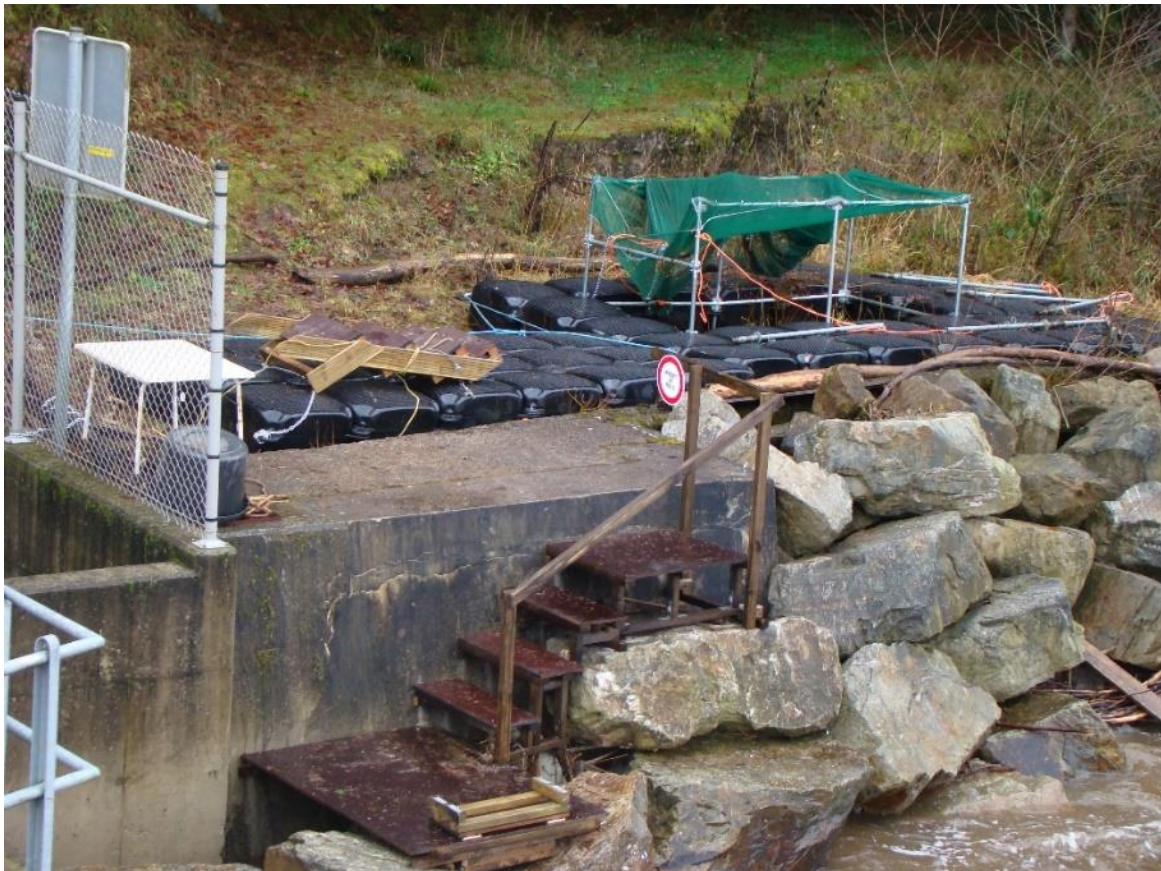
Figure 5 : Retrait du piège de dévalaison lors de pics de débit ( >30\text{m}^3/\text{s} )
