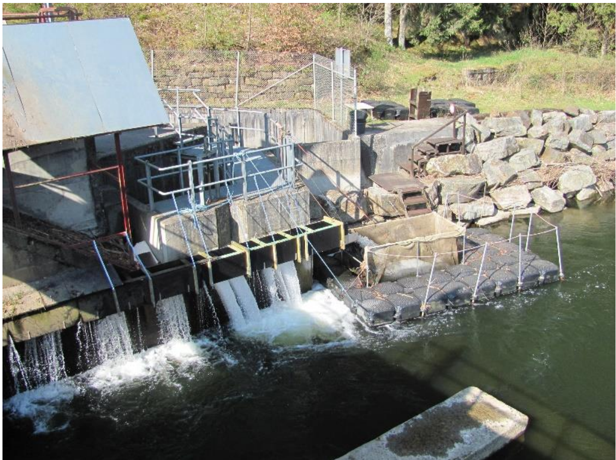
Figure 3 : Vue globale du piège de capture à la dévalaison au niveau du barrage de Lorcé
