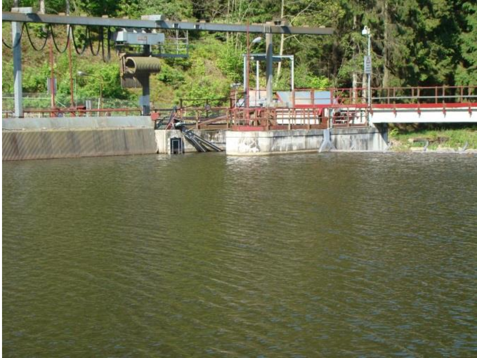
Figure 7 : Vue amont du barrage de Lorcé avec la présence de l'exutoire de dévalaison en rive gauche juste en aval du plan de grille
