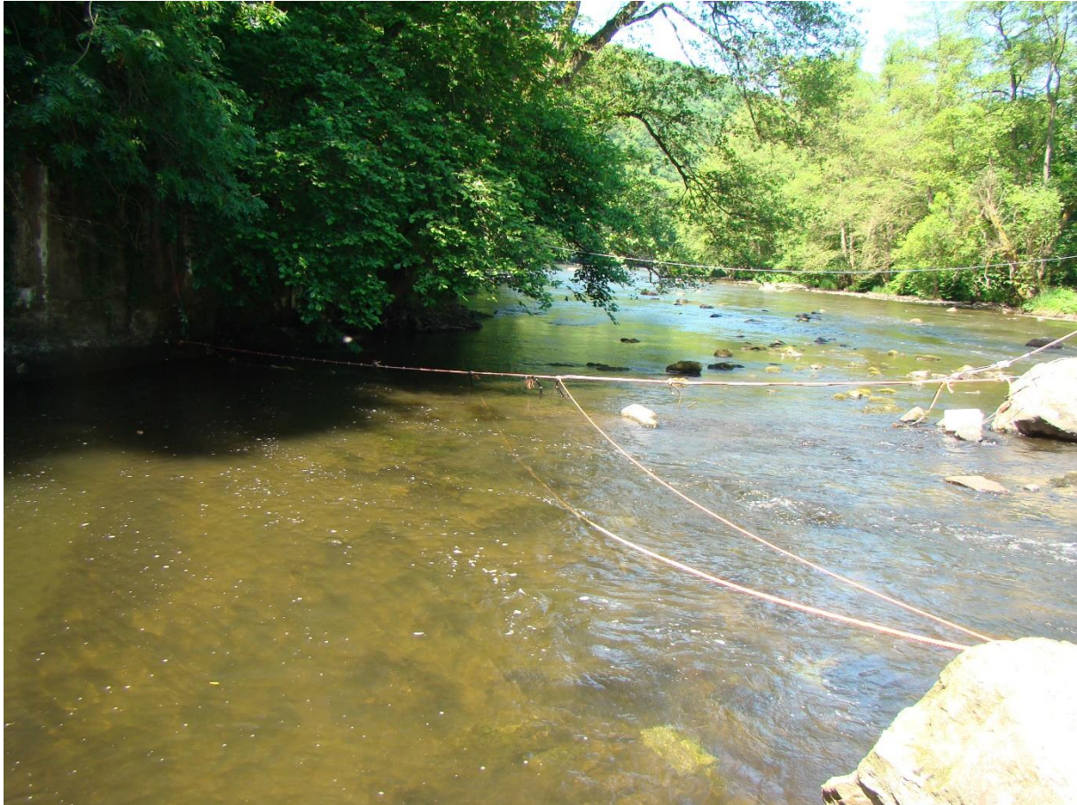
Figure 4 : Antennes RFID installées dans le canal de fuite de la centrale hydroélectrique de Heid de Goreux
