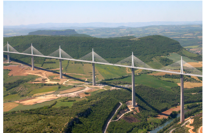
Viaduc de Millau (2460m), France
