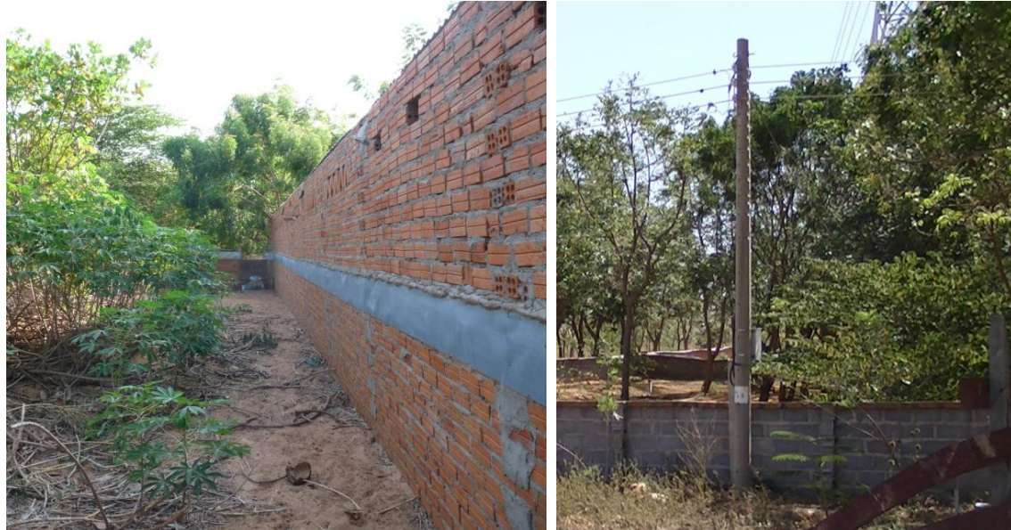
Figure 6.3 : Enclos en briques (gauche, photo Rochette A.-J.) et en parpaings (droite, photo Nguyen T.T.)
