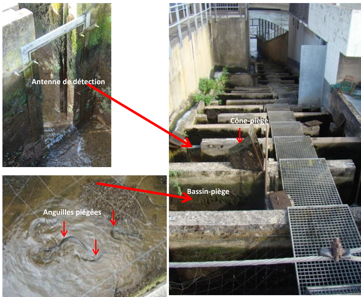
Figure 3: L'ancienne échelle à poissons : l'antenne de détection RFID, le bassin-piège, le cône-piège et les anguilles piégées dans le bassin-piège, au barrage de Lixhe à Visé sur la Meuse belge.
