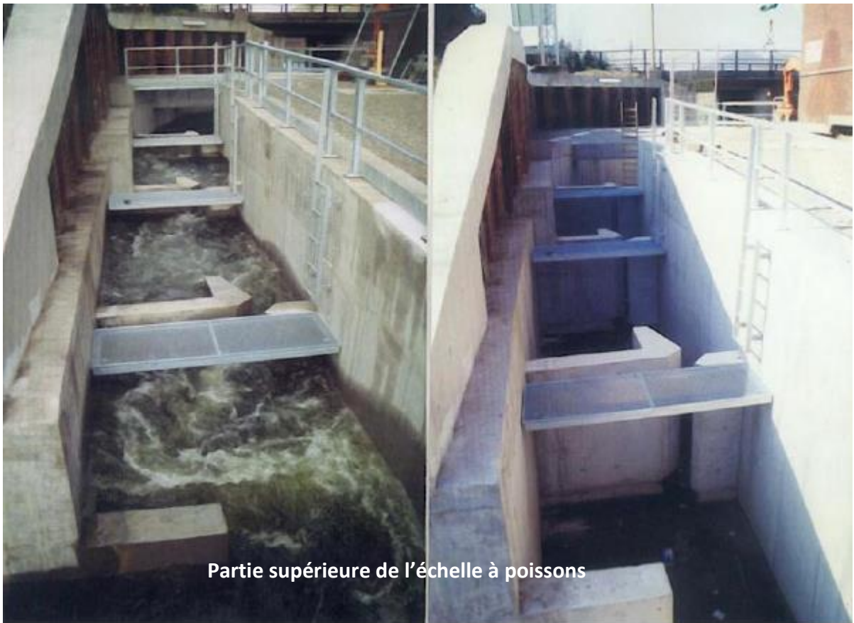
Figure 7: Vues de l'échelle à poissons du barrage de Monsin sur la Meuse belge (Philippart et al. 2010)
