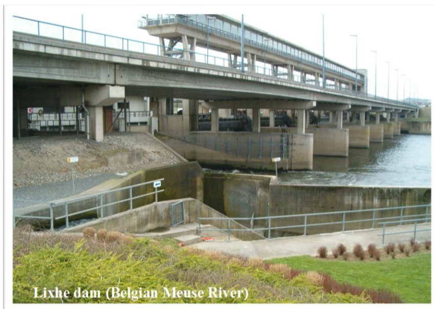
Figure 1: Barrage de Lixhe à Visé sur la Meuse belge près de la frontière avec les Pays-Bas.
