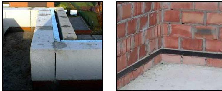
Fig. 107 : Exemples d'interposition d'un élément isolant
