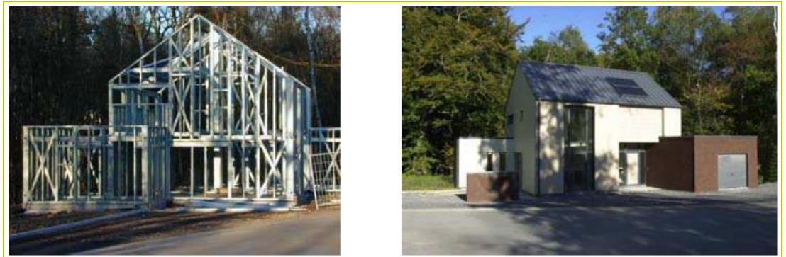
Fig. 20 : exemple d'une maison expérimentale construite avec le principe Styltech
