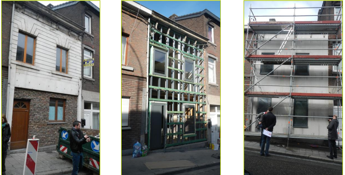
Fig. 25 : Façade du bâtiment « Molinay 34 » avant rénovation (à gauche), pendant le montage de la nouvelle façade Styltech (au centre) et en cours de finition (à droite).
