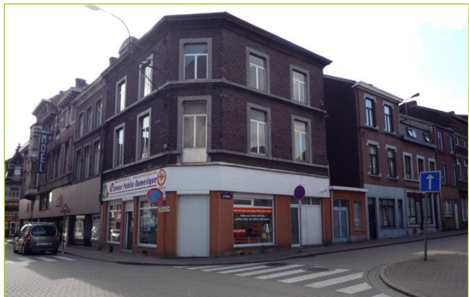
Fig. 14 : Premier bâtiment choisi pour rénovation (Ferrer 13)
