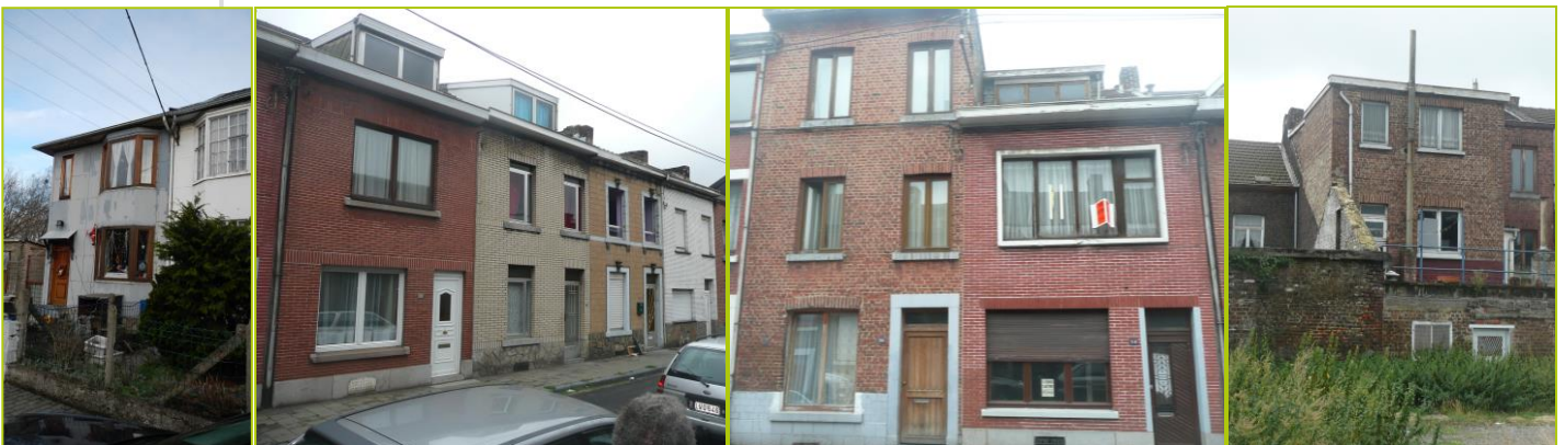
Fig. 13 : Exemple de maisons sérésiennes visitées et envisagées pour rénovation
