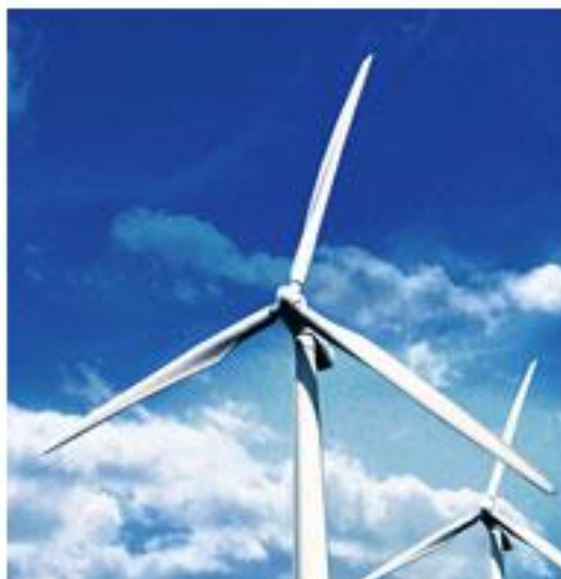
Figure 12 Pales d'éoliennes fabriquées à partir de composites renforcés de fibres de carbone
