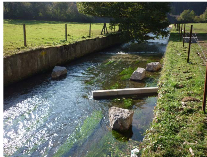
Déflecteurs « L » béton
